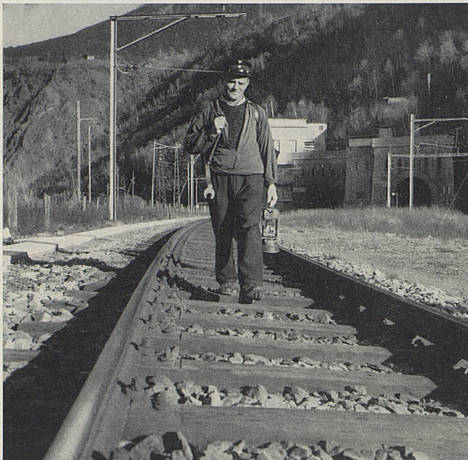
Retour d'une ronde de contrôle dans le tunnel du Simplon
