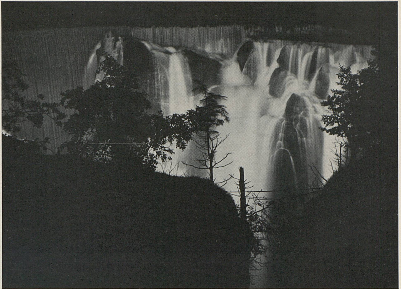
La ligne du Saint-Gothard illuminée: Le déversoir du bassin de compensation de Pfaffensprung (usine d'Amsteg)
