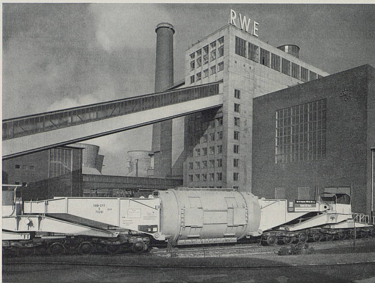
Le nouveau wagon CFF pour transports lourds, 18 essieux, 98 tonnes de tare et 270 tonnes de limite de charge, à son arrivée dans l'usine électrique allemande à laquelle le chargement est destiné.
