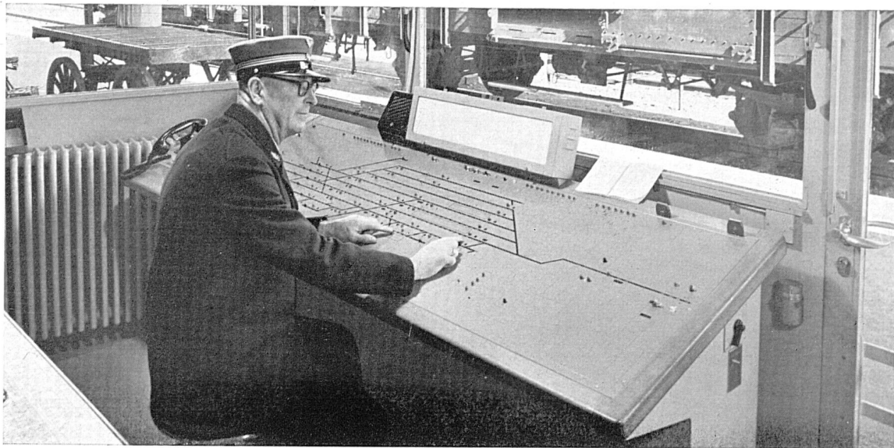
Le chef de gare manipule l'enclenchement électrique ultra-moderne, pourvu du pupitre avec tableau de commande synoptique
