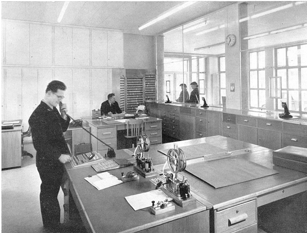
Un bureau de station moderne
