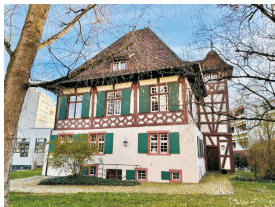
Abb. 3 Das ehemalige Weiherschloss "Unteres Mittleres Gundeldingen", das älteste noch bestehende Gebäude im Quartier, das im 16. Jahrhundert vom Humanistischen Gelehrten und Gymnasialrektors Thomas Platter und seinem Sohn Felix bewohnt wurde.
