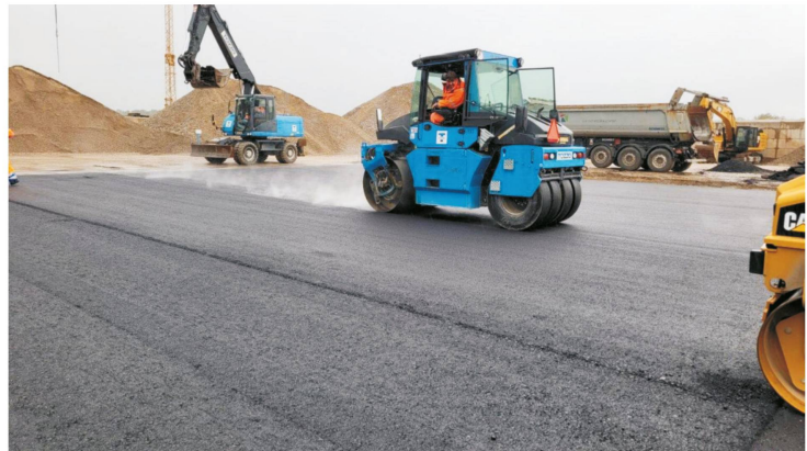
Abb. 3 Um mehr CO 2 -Äquivalent dauerhaft im Strassenbau zu speichern, setzt die Stadt Basel auf neuartigen Biokohle-Asphalt.
