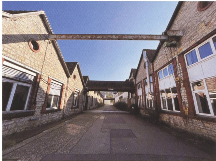
Abb. 3 Lauffenmühle-Areal in Lörrach-Brombach.
