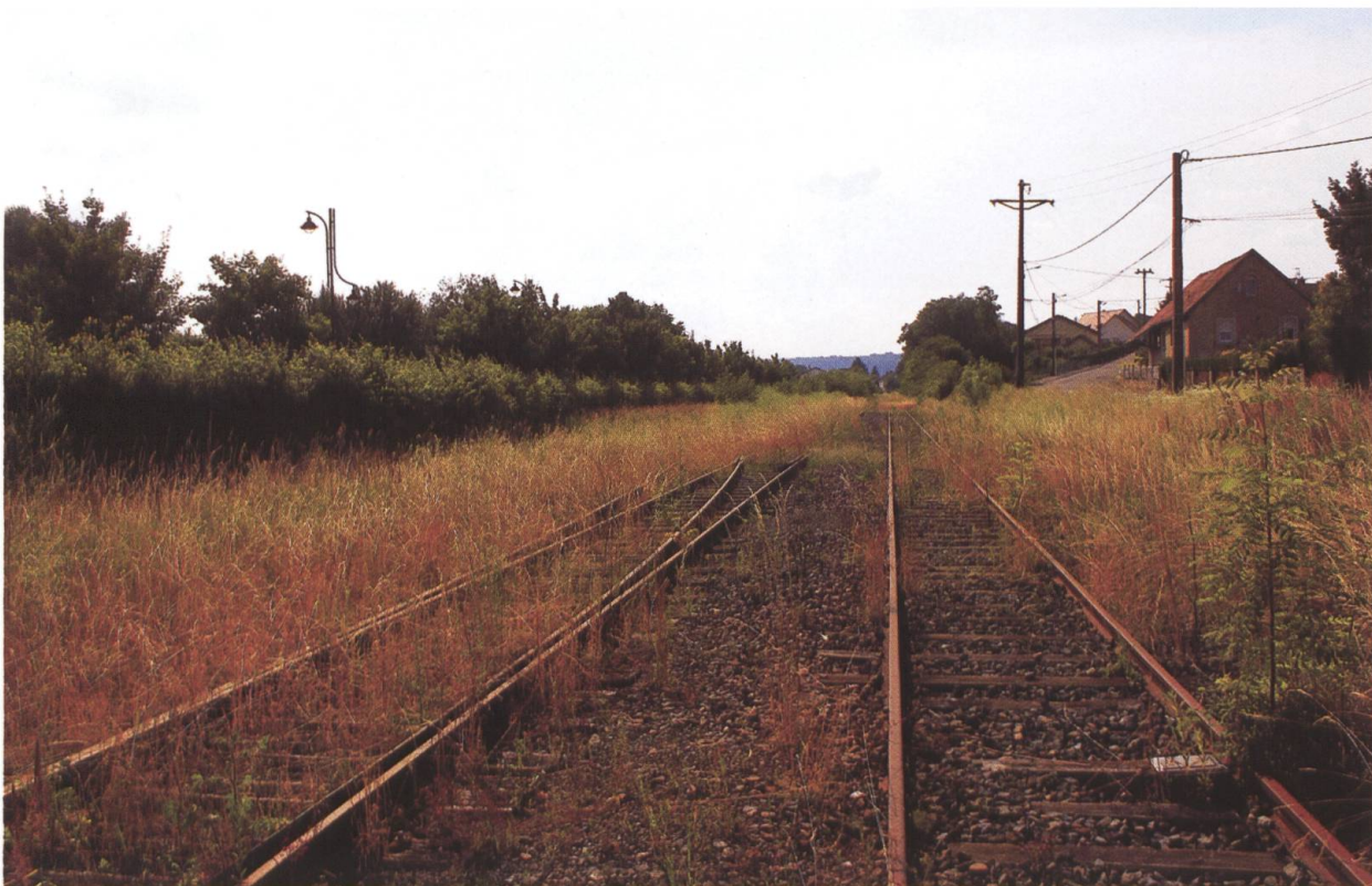
Abb. 2 Das typische Bild einer “koordinierten” Strecke in Frankreich (per Gesetz wurde eine Koordination zwischen sich konkurrierenden Bus- und Bahnlinien durchgeführt, was in vielen Fällen dazu führte, dass der Regionalverkehr auf die Strasse verlegt wurde): Die Natur erobert sich das Bahntrasse zurück, der Unterhalt wird vernachlässigt, so dass die Strecke auch für einen allfällig (und vorerst) noch verbleibenden Güterverkehr unattraktiv wird (Morvillars, 19. Juli 2013). Foto: O. Stucki
