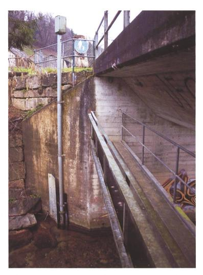
Abb. 10 Abflussmessstation Bubendorf Morgental; Limnigraph und Messbrücke (4. Januar 2023). Foto: O. Stucki
