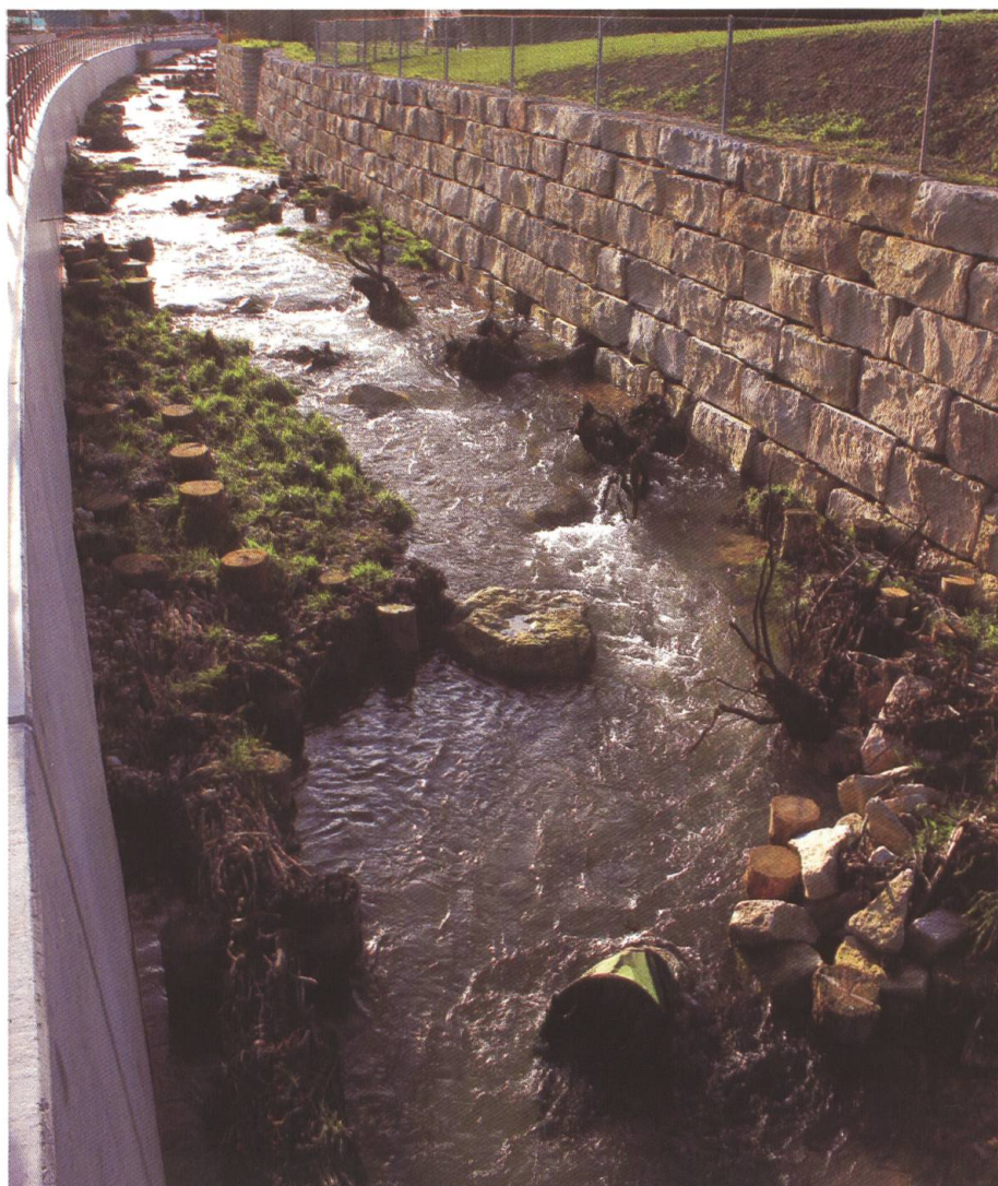
Abb. 3 Hochwasserschutzmassnahmen Reigoldswil, Unterbiel, Blick bachaufwärts. Kleinere Hochwasserereignisse haben die ursprüngliche Gestaltung des Bachbetts bereits überformt (31. Dezember 2022).
