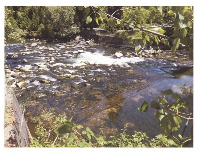
Abb. 7 Die revitalisierte Birs bei der ehemaligen Sohlenstufe. Hier wurde eine unpassierbare Sohlenstufe durch eine durchgängige Sohlenrampe aus Uferblöcken ersetzt. Foto: C. Wüthrich
