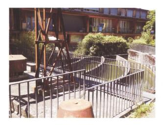
Abb. 10 Industriekanal der ehemaligen Schappeproduktion in Arlesheim: (a; links) Maschinenkanal als Abzweiger vom Industriekanal. (b; rechts) Fischtreppe, welche den Fischen den Aufstieg in den alten Industriekanal ermöglichen soll und von dort eine Verbindung zur Birs oberhalb des Kraftwerks herstellt. Fotos: C. Wüthrich
