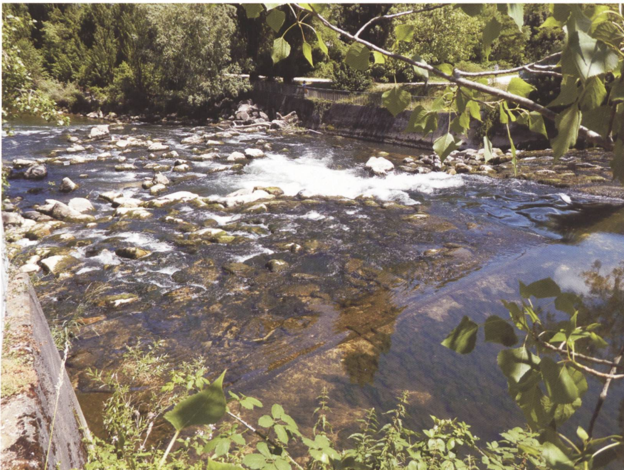
Abb. 7 Die revitalisierte Birs bei der ehemaligen Sohlenstufe. Hier wurde eine unpassierbare Sohlenstufe durch eine durchgängige Sohlenrampe aus Uferblöcken ersetzt.
