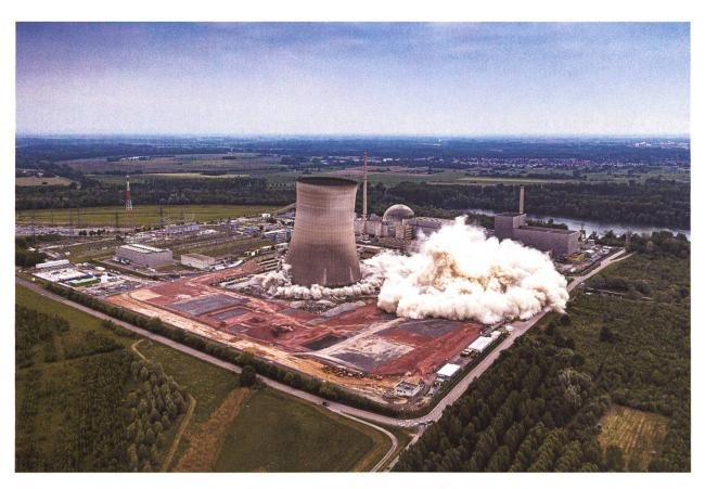
Abb. 1 Am 14. Mai 2020 wurden die beiden Kühltürme des AKW Philippsburg gesprengt, die im nördlichen oberrheinischen Tiefland bisher weithin als Landmarke sichtbar waren. Foto: Drohne EnBW
