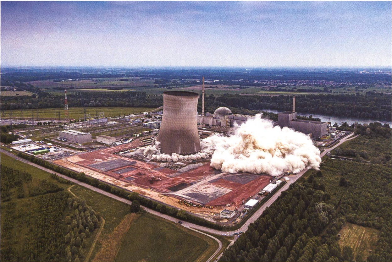
Abb. 1 Am 14. Mai 2020 wurden die beiden Kühltürme des AKW Philippsburg gesprengt, die im nördlichen oberrheinischen Tiefland bisher weithin als Landmarke sichtbar waren. Foto: Drohne EnBW
