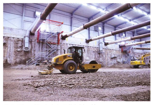
Abb. 21 Walzen verdichten das eingebrachte frische Erdmaterial.
