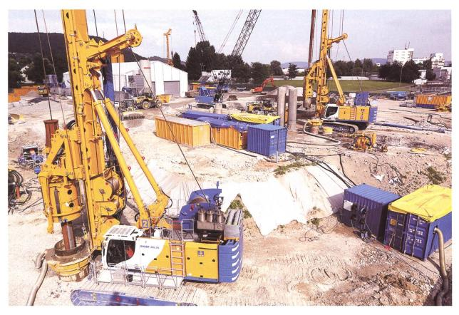
Abb. 13 Austausch- und Verbaubohrungen mit Grossdrehbohrgeräten des Typs BG 39. Dabei wird eine Bohrpfahlwand bis in eine Tiefe von 23 m unter Geländeoberkante erstellt.
