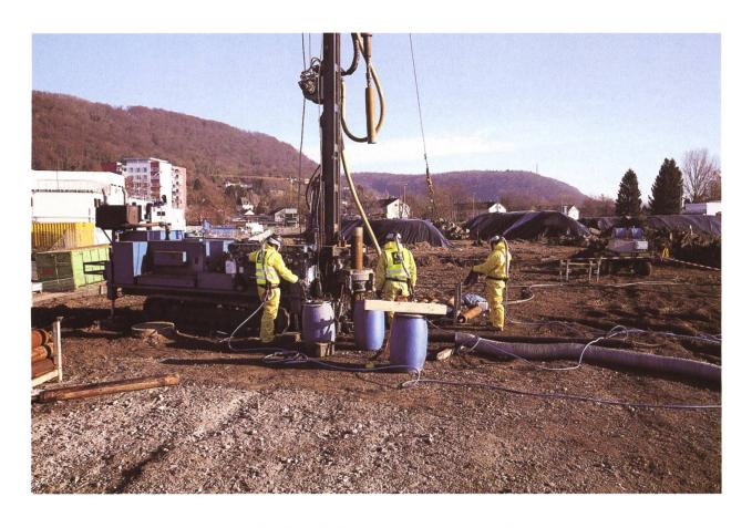
Abb. 7 (oben) und Abb. 8 (unten) 2015 und 2016 wurden insgesamt 142 Erkundungsbohrungen bis in eine Tiefe von -13 m durchgeführt.
