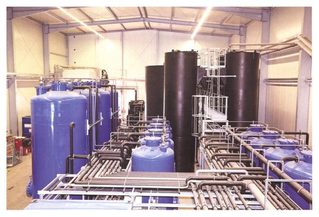
Abb. 14 Blick auf die mehrstufige Grundwasserreinigungsanlage.
