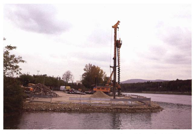
Abb. 10 Auflockerungsbohrungen zur Erstellung der Spundwandtrassee beim Bau des Schiffsanlegers.
