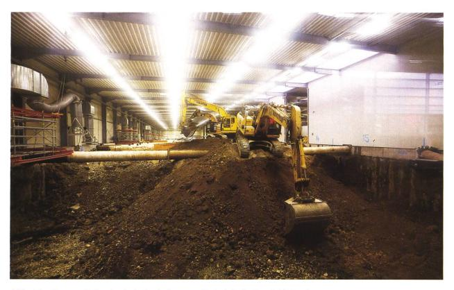
Abb. 15 Bagger beim Aushub des belasteten Erdreichs in Baufeld Nord.
