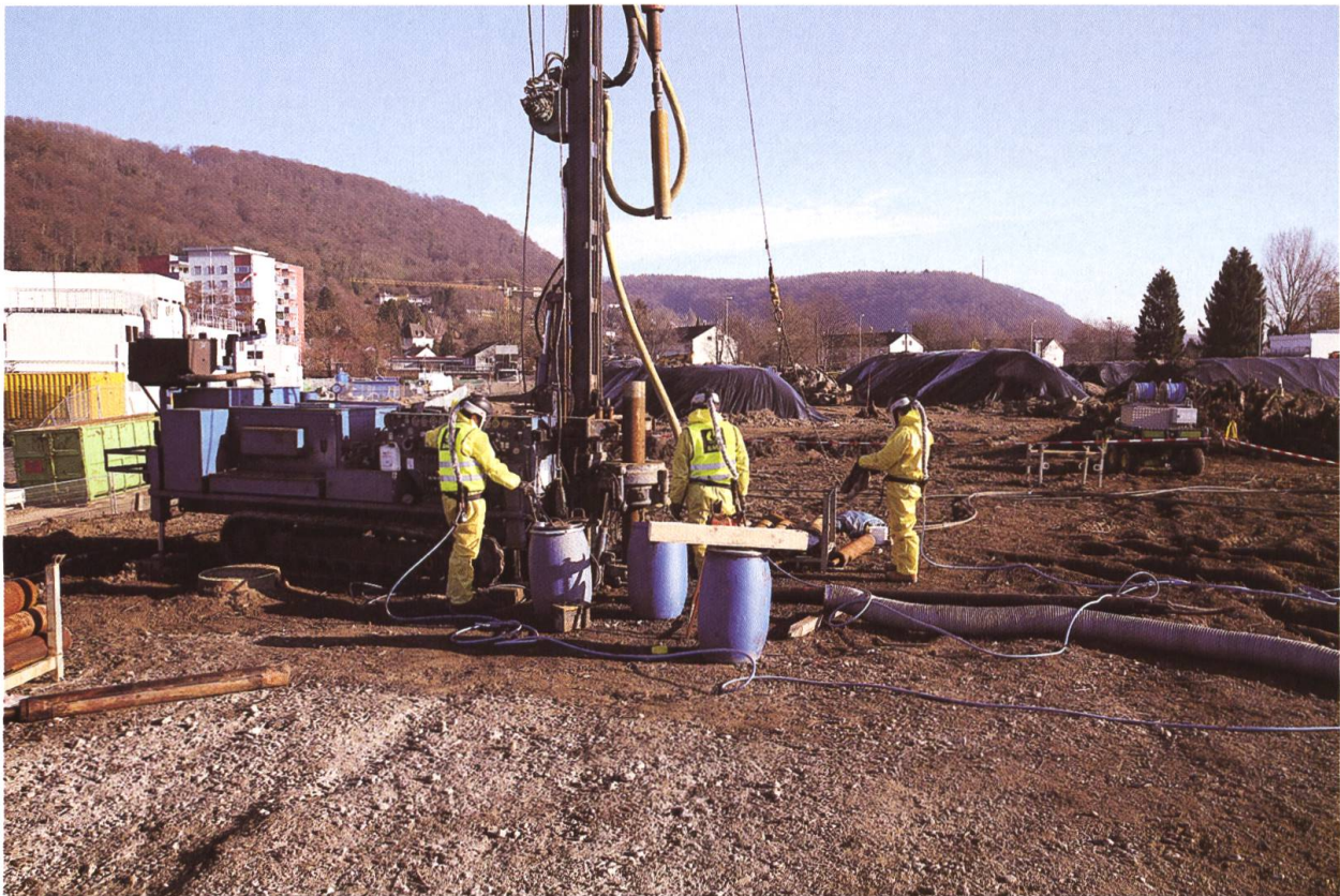
Abb. 7 (oben) und Abb. 8 (unten) 2015 und 2016 wurden insgesamt 142 Erkundungsbohrungen bis in eine Tiefe von -13 m durchgeführt.
