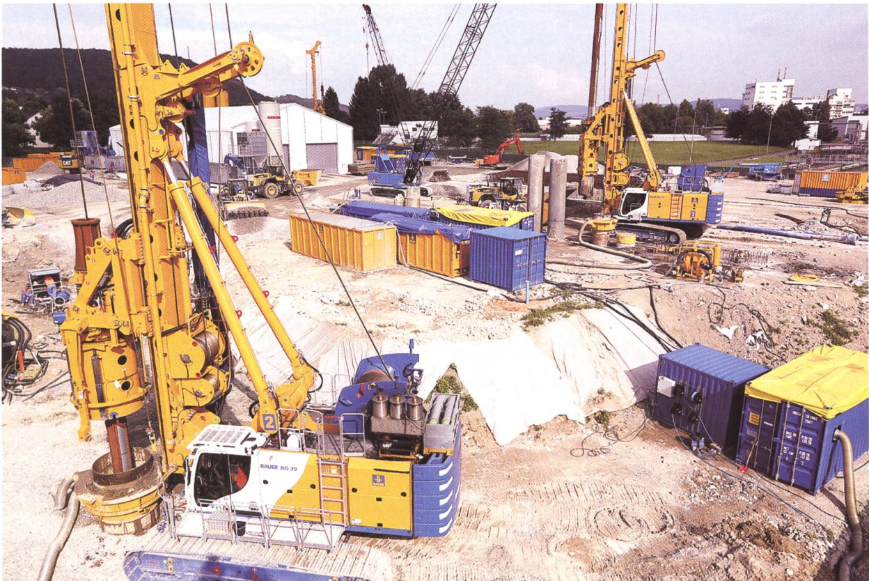
Abb. 13 Austausch- und Verbaubohrungen mit Grossdrehbohrgeräten des Typs BG 39. Dabei wird eine Bohrfahlfwand bis in eine Tiefe von 23 m unter Geländeoberkante erstellt.
