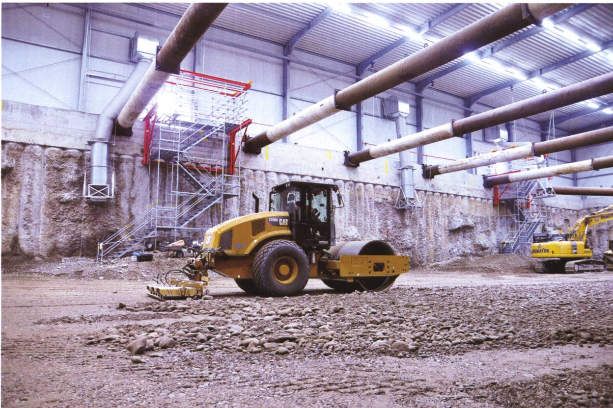
Abb. 21 Walzen verdichten das eingebrachte frische Erdmaterial.
