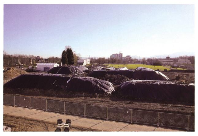
Abb. 5 Haufwerke mit unbelastetem Oberflächenerdreich nach Nivellierung des Sanierungsareals.
