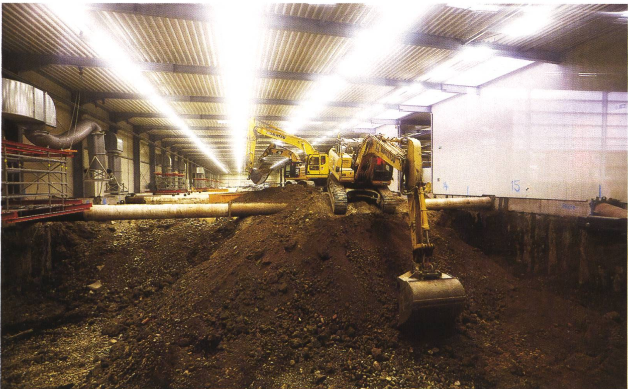
Abb. 15 Bagger beim Aushub des belasteten Erdreichs in Baufeld Nord.
