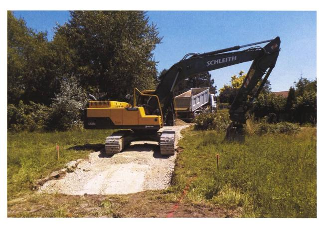
Abb. 2 Herstellung der Ausweichtrasse für den von der Sanierung temporär entfernten Salzländeweg.
