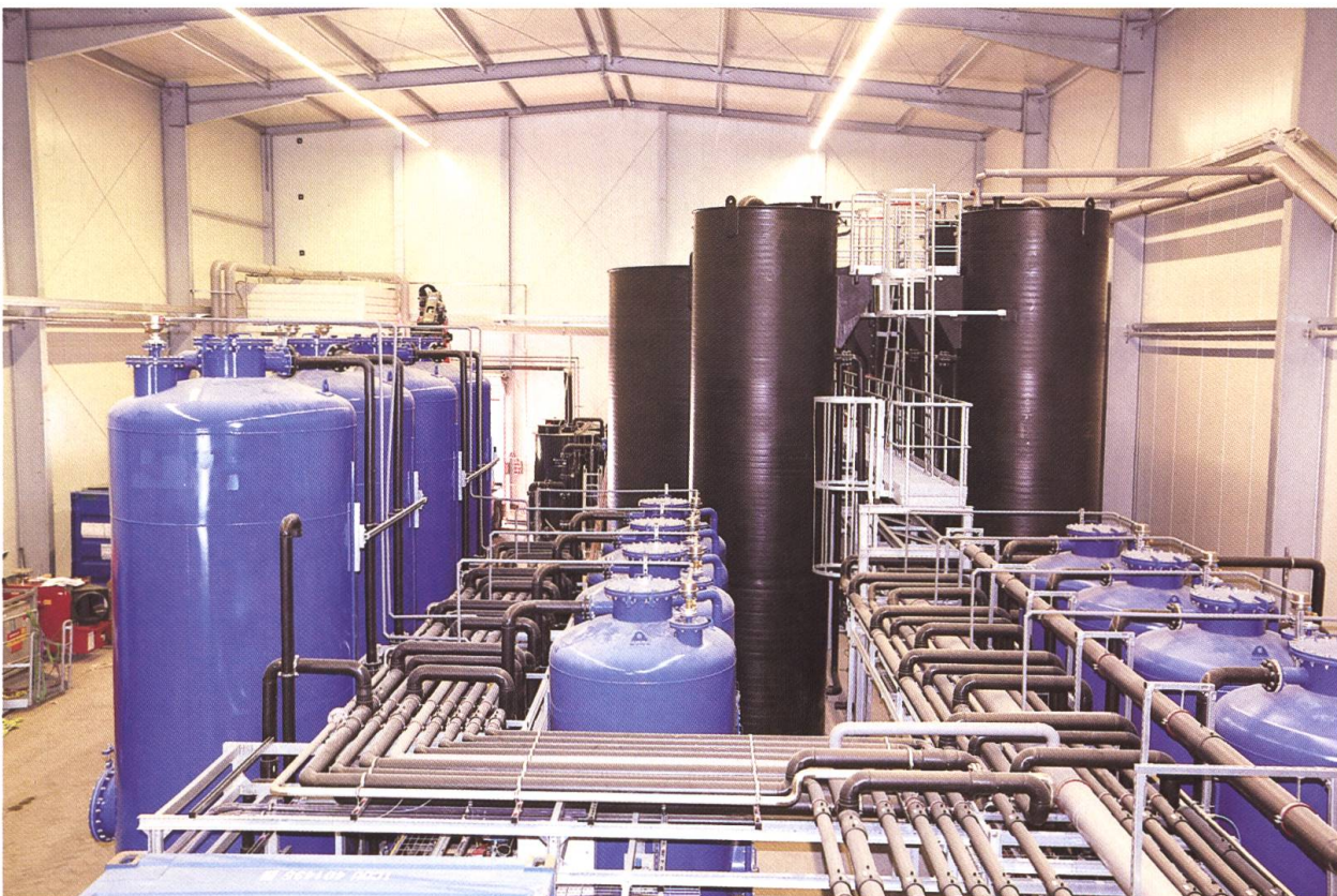
Abb. 14 Blick auf die mehrstufige Grundwasserreinigungsanlage.
