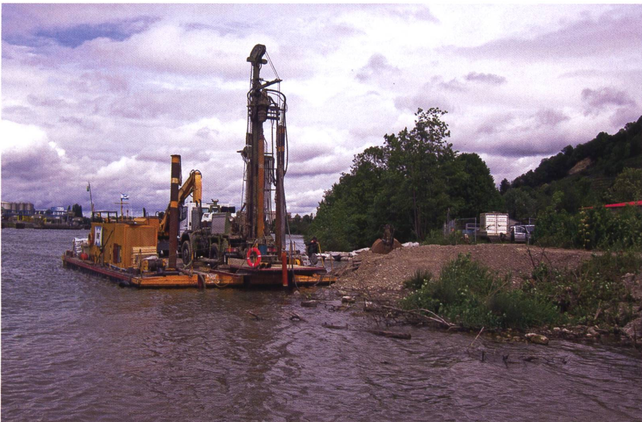
Abb. 3 Baugrunderkundung im Bereich des projektierten temporären Schiffsanlegers zum An- und Abtransport von belastetem Erdmaterial in gasdichten und havariesicheren Spezialcontainern.
