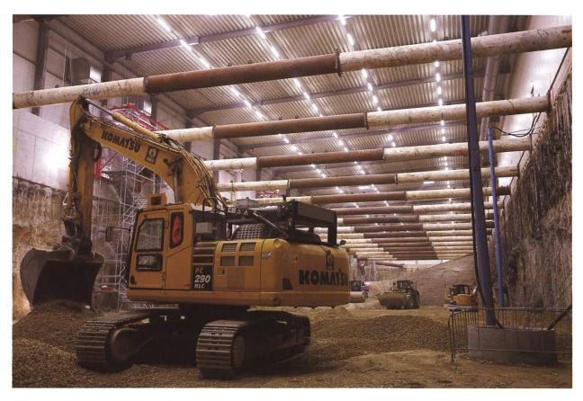
Abb. 20 Wiederverfüllung des sanierten Baufelds mit frischem Erdmaterial, u. a. aus der nahegelegenen Rheinauskiesung Efringen-Kirchen.
