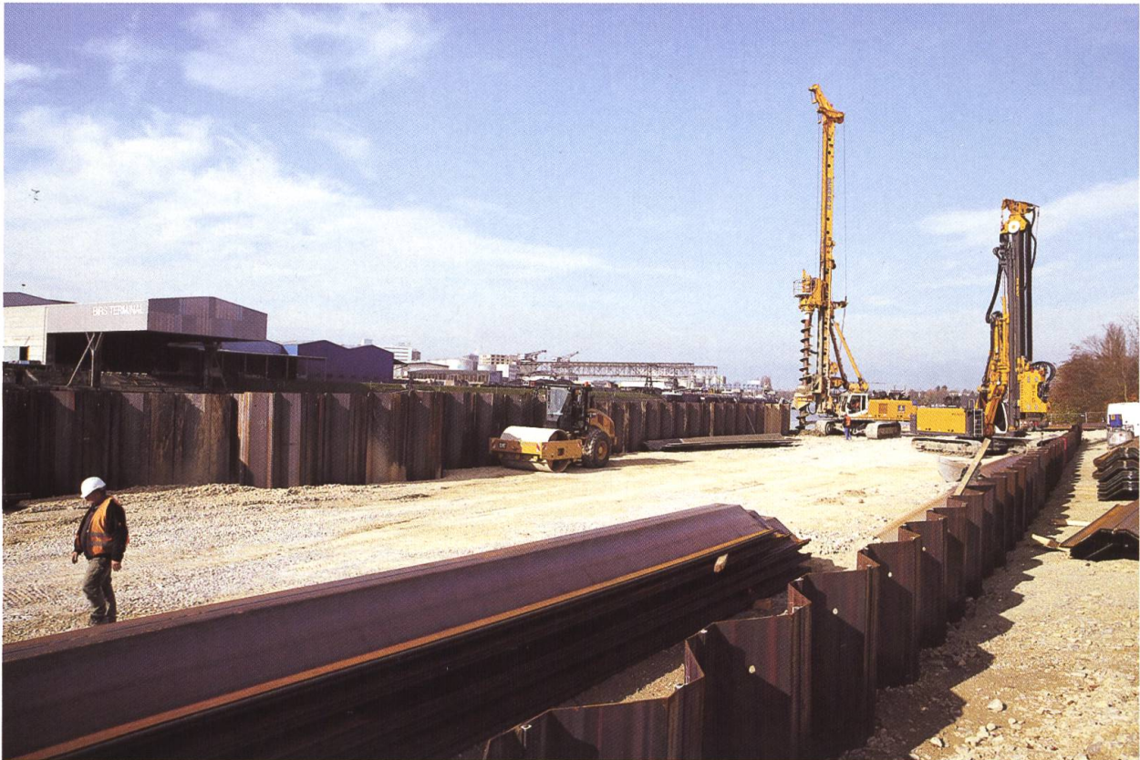
Abb. 11 Der Schiffsanleger wird mittels Spundwänden erstellt. In Abb. 6 ist die gesamthafte Ausdehnung des im Bau befindlichen Schiffsanlegers zu erkennen.
