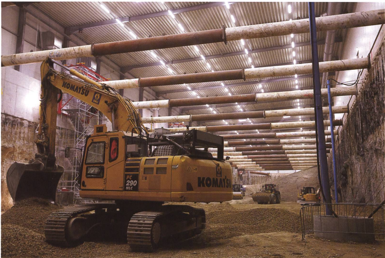
Abb. 20 Wiederverfüllung des sanierten Baufelds mit frischem Erdmaterial, u. a. aus der nahegelegenen Rheinauskiesung Efringen-Kirchen.
