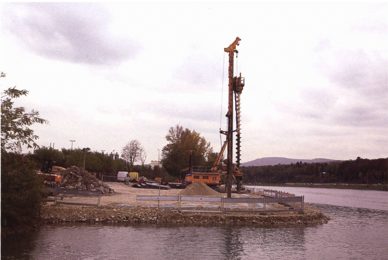
Abb. 10 Auflockerungsbohrungen zur Erstellung der Spundwandtrasse beim Bau des Schiffsanlegers.
