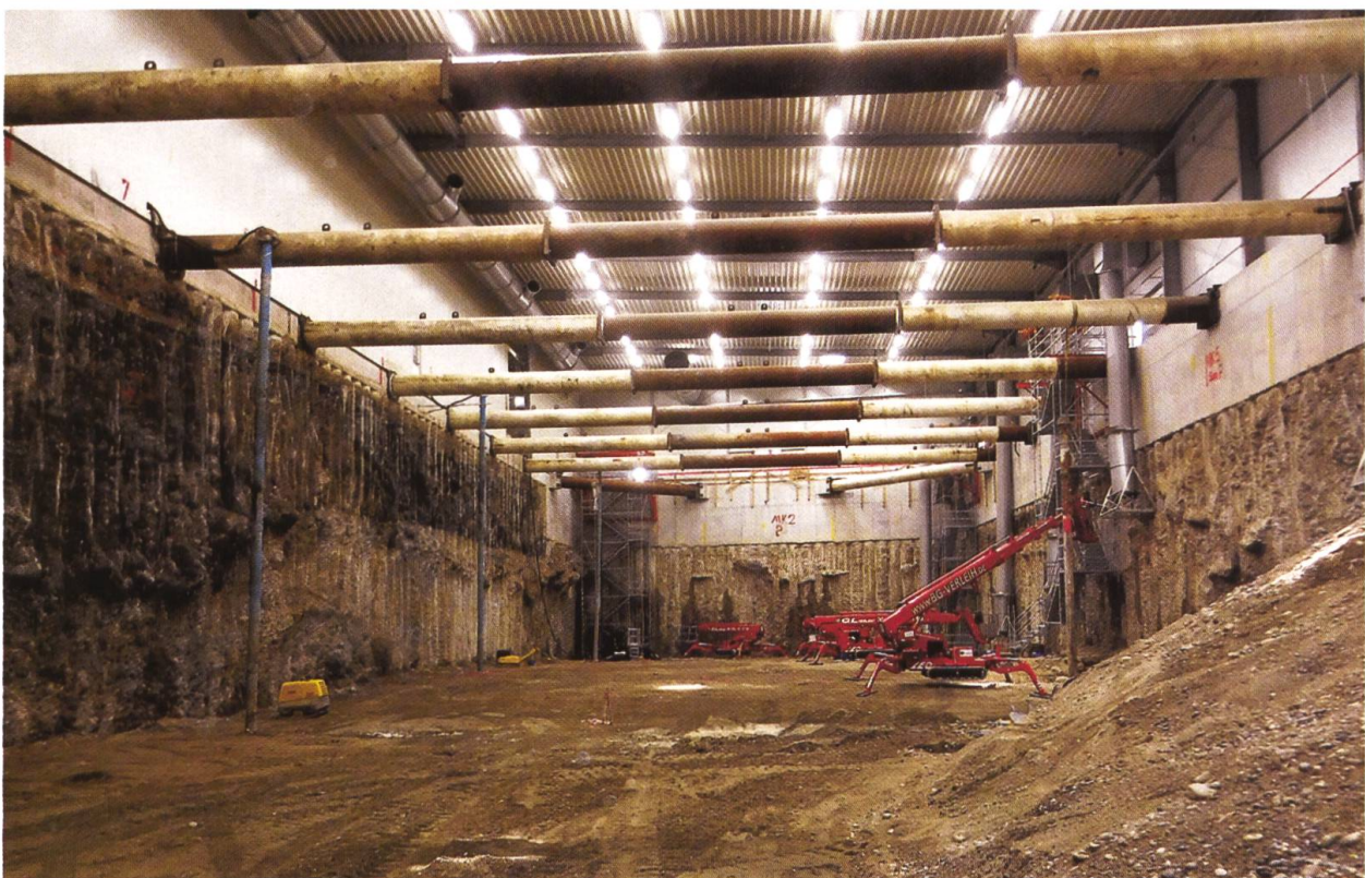
Abb. 19 Blick in das vollständig ausgehobene, von belastetem Erdreich befreite Baufeld Nord.
