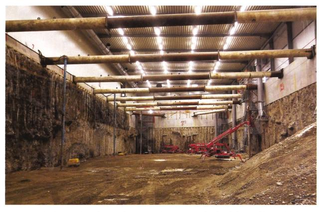
Abb. 19 Blick in das vollständig ausgehobene, von belastetem Erdreich befreite Baufeld Nord.
