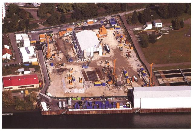
Abb. 12 Zur Sicherung des Aushubareals entsteht eine bis zu 23 m tiefe Bohrpfahlwand. Dabei wurden 888 sich überschneidende Bohrpfähle erstellt. Auf dem Bild sind drei (gelbe) Bohrgeräte erkennbar (vgl. Abb. 13), vorne rechts die Grundwasserreinigungsanlage (vgl. Abb. 14).
