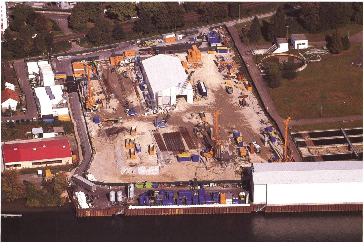
Abb. 12 Zur Sicherung des Aushubareals entsteht eine bis zu 23 m tiefe Bohrpflwand. Dabei wurden 888 sich überschneidende Bohrpfähle erstellt. Auf dem Bild sind drei (gelbe) Bohrgeräte erkennbar (vgl. Abb. 13), vorne rechts die Grundwasserreinigungsanlage (vgl. Abb. 14).
