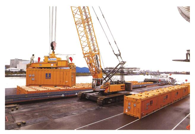
Abb. 16 Umschlag des belasteten Erdreichs in Spezialcontainern auf ein Binnenschiff.
