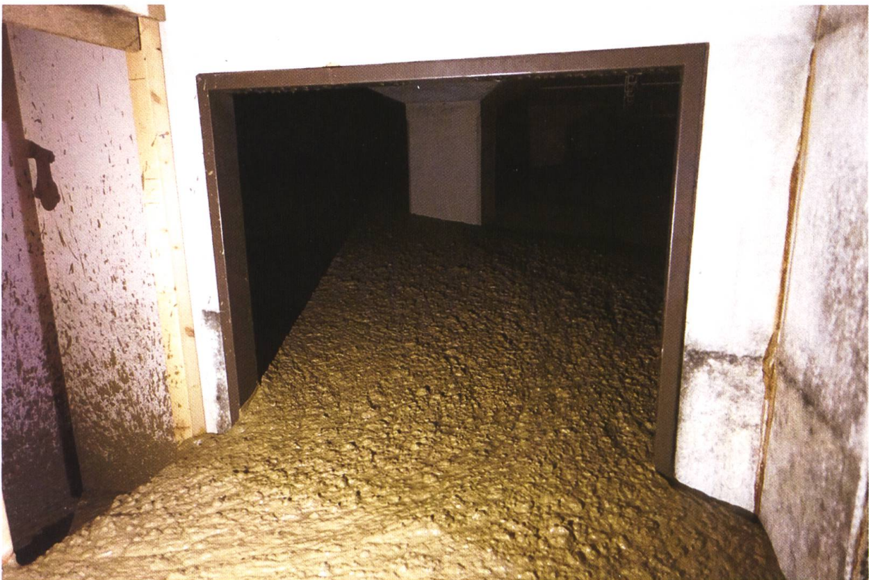
Abb. 5 Baustelle MuttENZ: Der Flüssigboden füllt die beiden Etagen komplett aus. Das sichert nicht nur die Statik für den künftigen Neubau, sondern spart auch Kosten.
