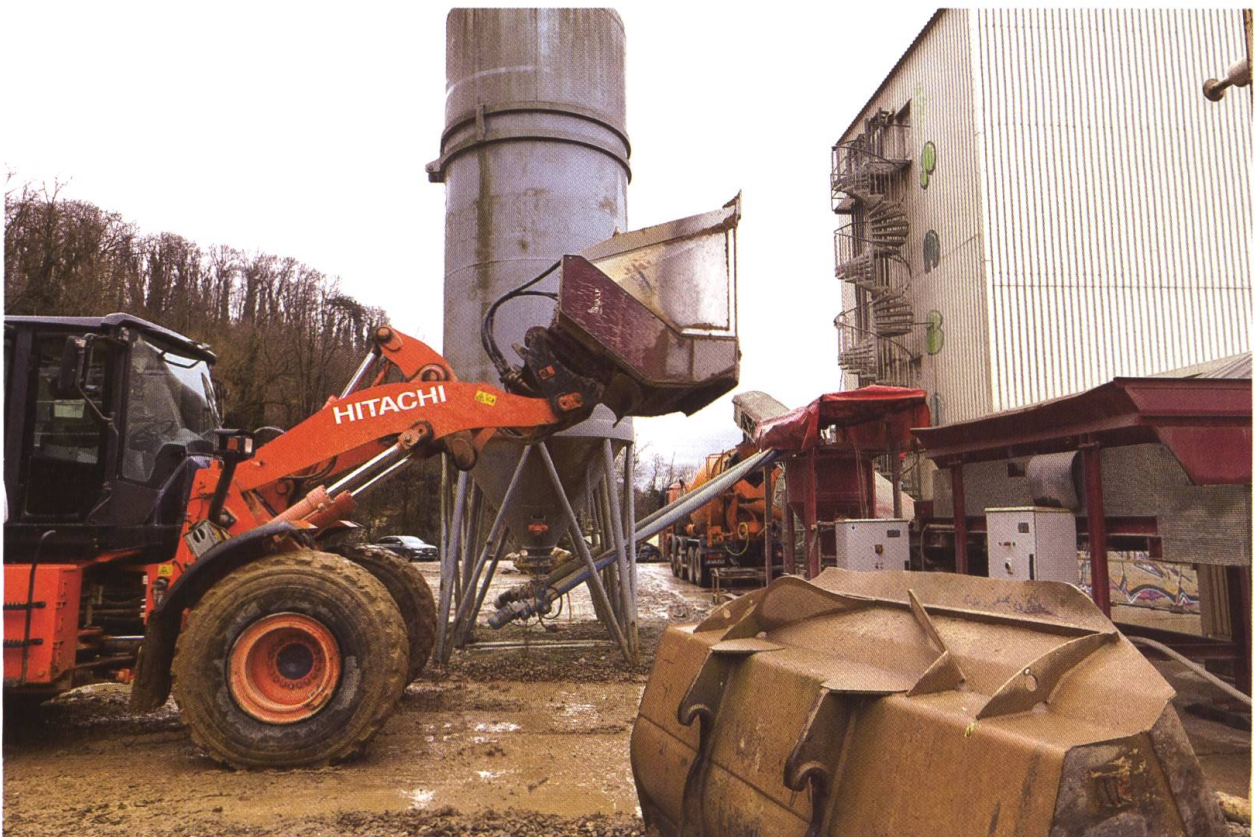
Abb. 4 Baustelle Rheinfelden: Der Bauaushub wird in einer Kompaktanlage in Flüssigboden umgewandelt und dann zur Verfüllung des Rohrgrabens verwendet.
