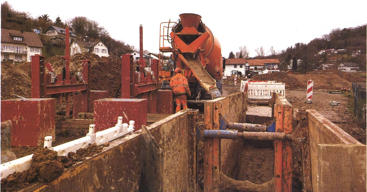
Abb. 3 Baustelle Rheinfelden: Der Bauaushub wird in Form von Flüssigboden wieder eingesetzt. Um ein Aufschwimmen der Rohre zu vermeiden, werden u. a. sogenannte Rohrverlegehilfen eingesetzt.
