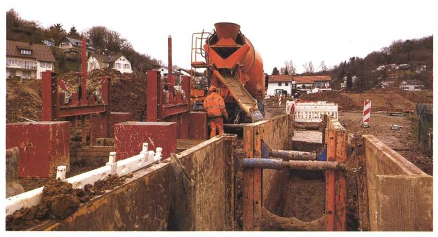
Abb. 3 Baustelle Rheinfelden: Der Bauaushub wird in Form von Flüssigboden wieder eingesetzt. Um ein Aufschwimmen der Rohre zu vermeiden, werden u. a. sogenannte Rohrverlegehilfen eingesetzt.
