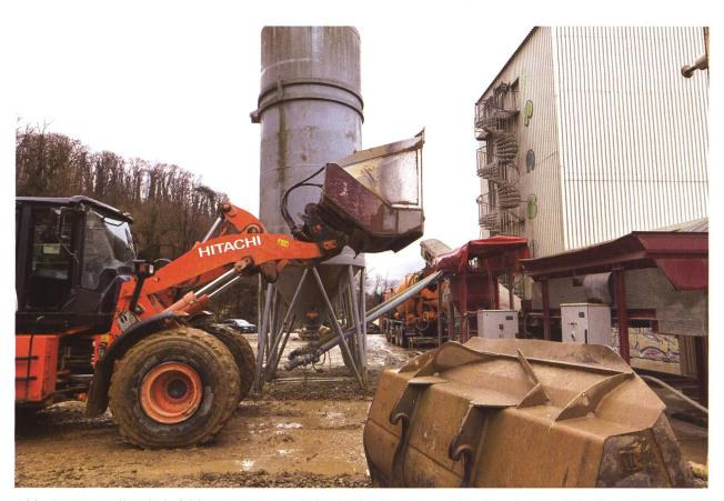
Abb. 4 Baustelle Rheinfelden: Der Bauaushub wird in einer Kompaktanlage in Flüssigboden umgewandelt und dann zur Verfüllung des Rohrgrabens verwendet. Foto: C. Bertoldi
