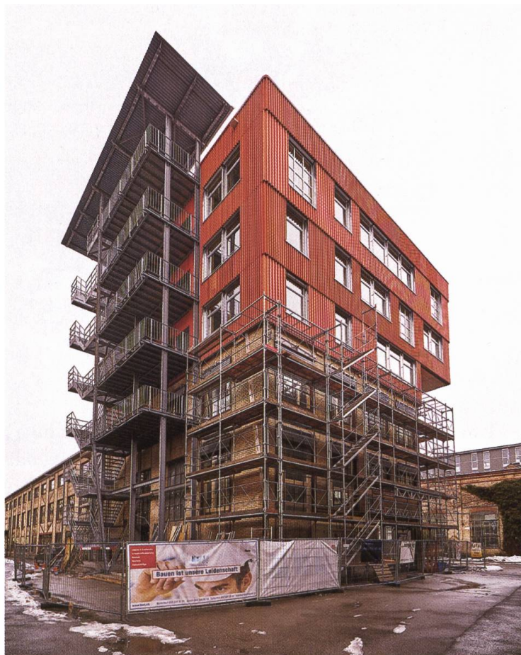
Abb. 2 Kopfbau K118, Lagerplatz Winterthur. Dreigeschossige Aufstockung aus 70 % wiederverwendetem Material.
