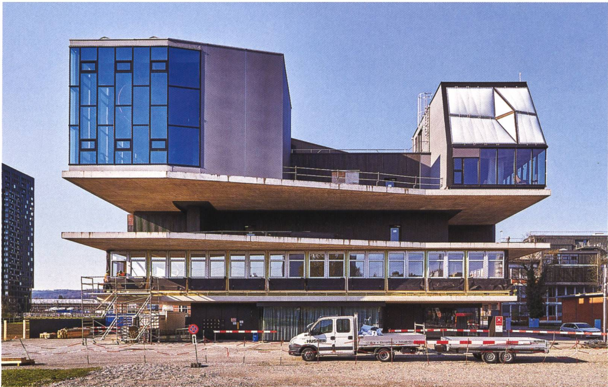
Abb. 3 NEST, Empa Dübendorf. Einbau Unit Sprint im 1.OG.
