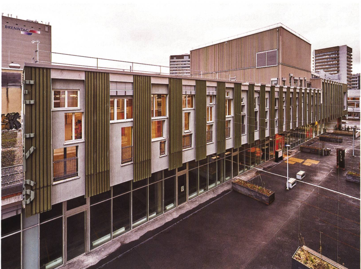
Abb. 1 Kultur- und Gewerbehaus ELYS, Lysbüchel Basel. Rund 1'000 m 2 Fassade mit wiederverwendetem Baumaterial.
