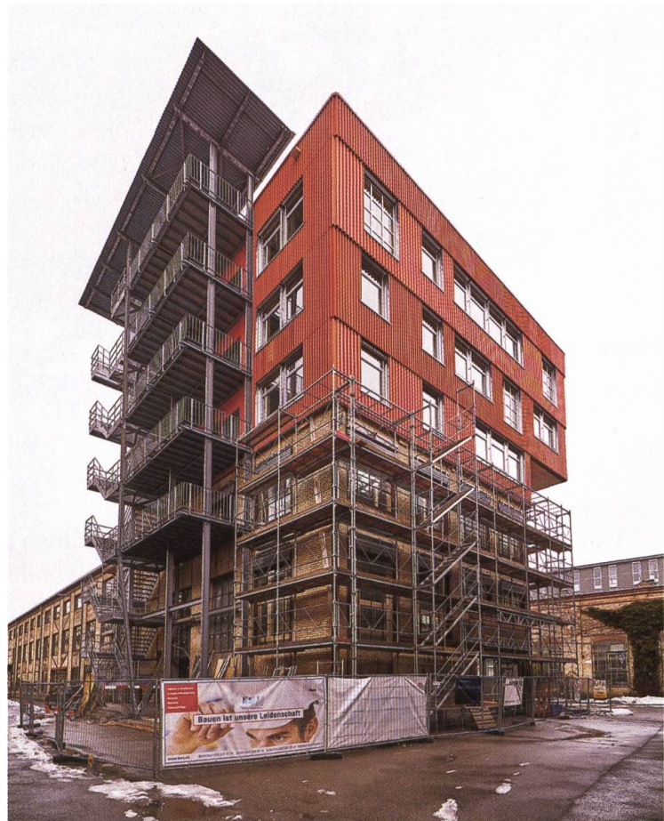
Abb. 2 Kopfbau K118, Lagerplatz Winterthur. Dreigeschossige Aufstockung aus 70 % wiederverwendetem Material.
