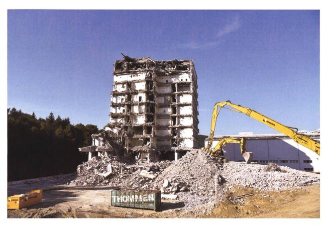
Abb. 4 Rückbau eines Betongebäudes im Raum Schweizerhalle bei Muttenz.
