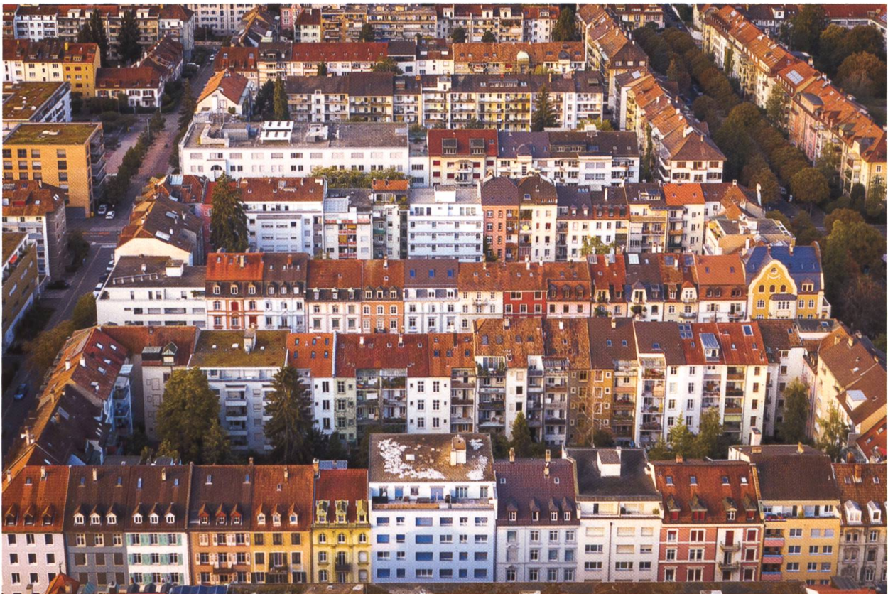
Abb. 5 Hausfassaden im Wohnviertel Gundeldingen in der Morgensonne.
