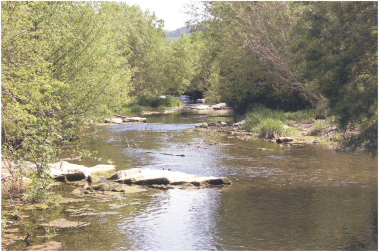
Abb. 7B Revitalisierter Abschnitt zwischen Liestal und Lausen. Die Beschattung durch Bäume und Sträucher ist gut. Der Einsatz von Buhnen sorgt für eine ausgewogene Breiten- und Tiefenvariabilität, fördert eine vielfältige Strömung und schafft Stillwasserbereiche. Das eingesetzte Totholz dient als Rückzugsort und Habitat für Jungfische. Blocksteine unterhalb von Schwellen sorgen für eine gute Längsvernetzung und ermöglichen das Wandern der Fische.
