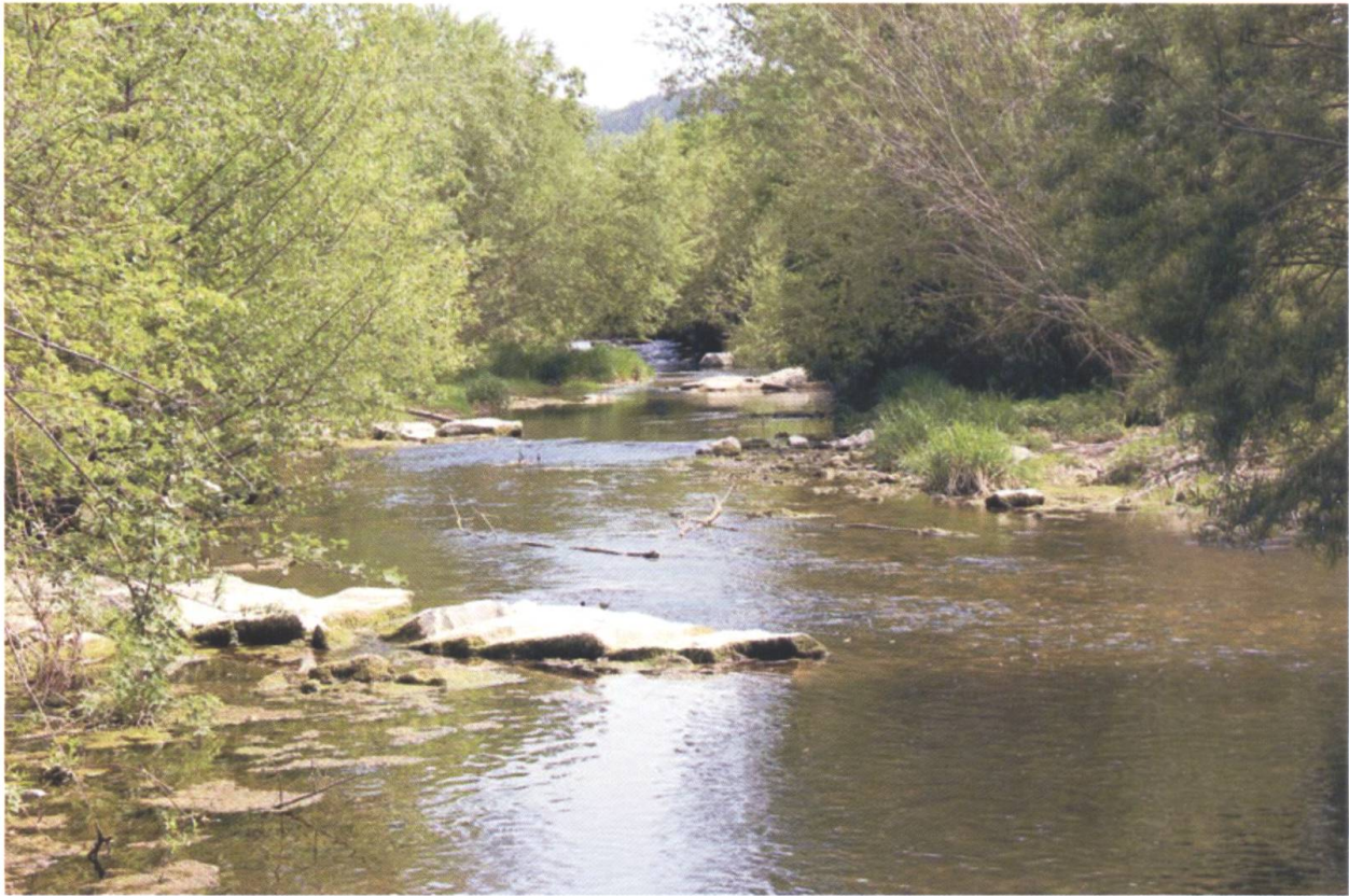
Abb. 7B Revitalisierter Abschnitt zwischen Liestal und Lausen. Die Beschattung durch Bäume und Sträucher ist gut. Der Einsatz von Buhnen sorgt für eine ausgewogene Breiten- und Tiefenvariabilität, fördert eine vielfältige Strömung und schafft Stillwasserbereiche. Das eingesetzte Totholz dient als Rückzugsort und Habitat für Jungfische. Blocksteine unterhalb von Schwellen sorgen für eine gute Längsvernetzung und ermöglichen das Wandern der Fische. Foto: D. Zahno
