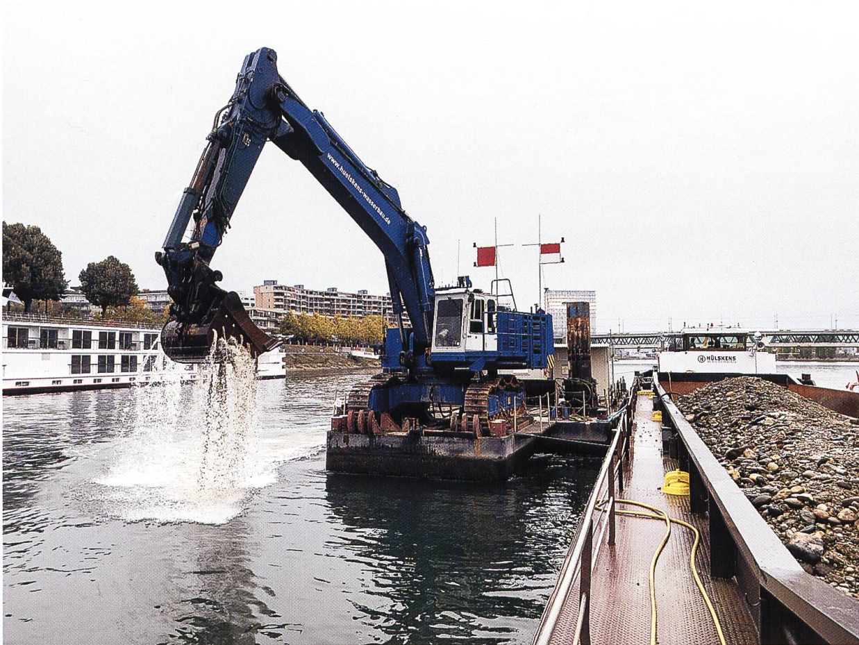
Abb. 9 Ponton sowie Hydraulikbagger mit Felslöffel im Einsatz.
