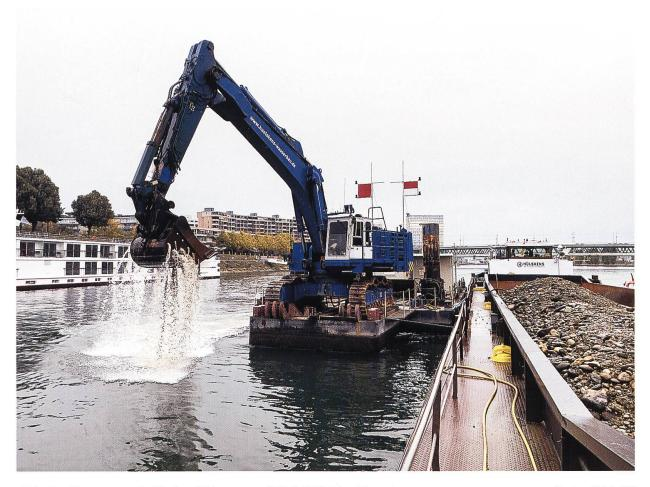
Abb. 9 Ponton sowie Hydraulikbagger mit Felslöffel im Einsatz.
