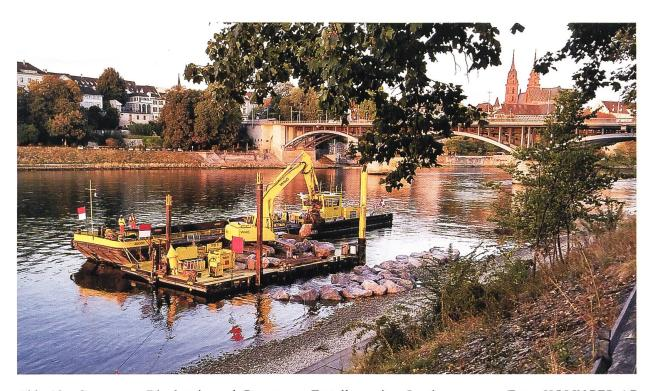
Abb. 12 Setzen von Blocksteinen ab Ponton zur Erstellung einer Insel.
