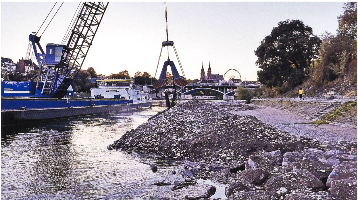
Abb. 14 Kiesübergabe aus der Baggerung in der Fahrrinne am Kleinbasler Ufer. Foto: HOLINGER AG
