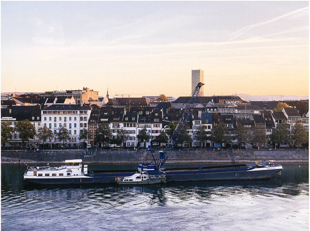
Abb. 10 Kranschiff mit Seilbagger.
