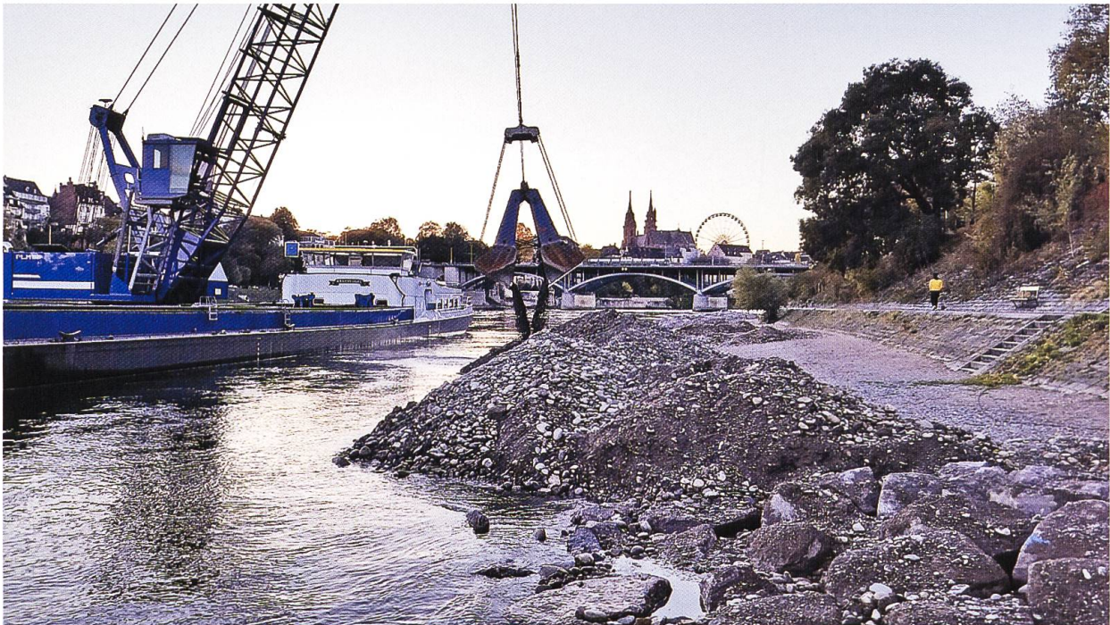
Abb. 14 Kiesübergabe aus der Baggerung in der Fahrrinne am Kleinbasler Ufer. Foto: HOLINGER AG
