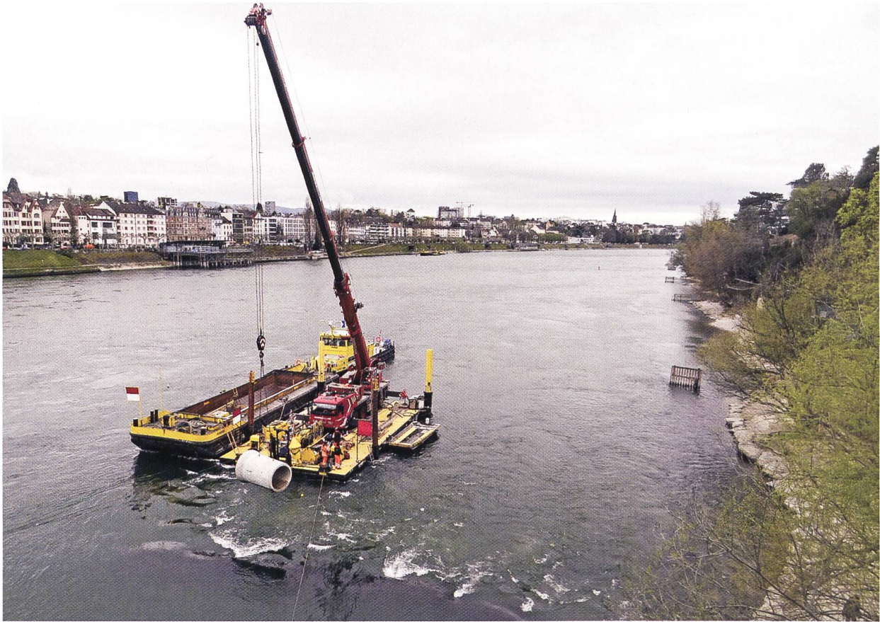
Abb. 13 Versetzen eines Betonrohrelements ab Ponton unter Beihilfe von Tauchern im Schutz eines Strömungsabweisers aus Blocksteinen. Foto: HOLINGER AG
