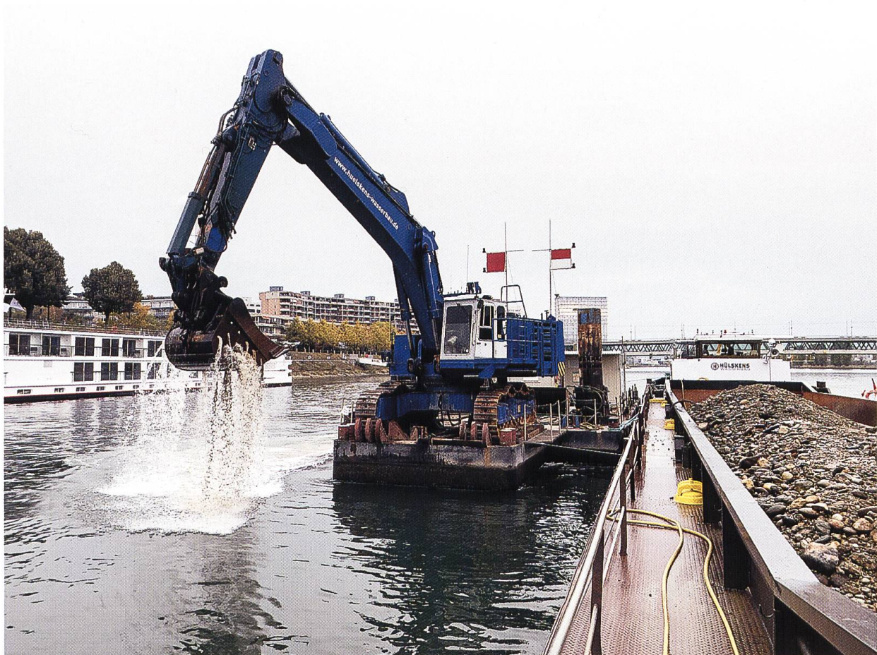
Abb. 9 Ponton sowie Hydraulikbagger mit Felslöffel im Einsatz.
