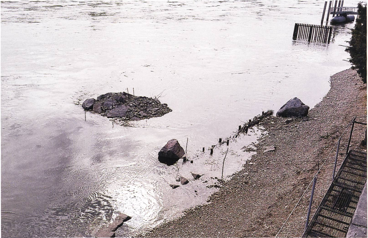
Abb. 15 Insel mit Weidenstecklingen, Faschinen und Störsteine am Ufer.
