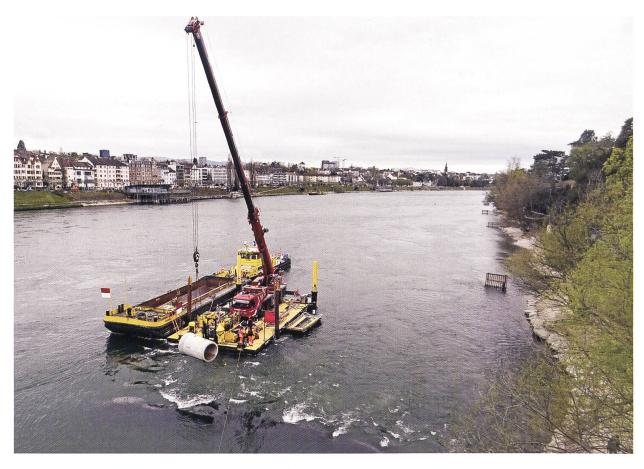
Abb. 13 Versetzen eines Betonrohrelements ab Ponton unter Beihilfe von Tauchern im Schutz eines Strömungsabweisers aus Blocksteinen. Foto: HOLINGER AG
