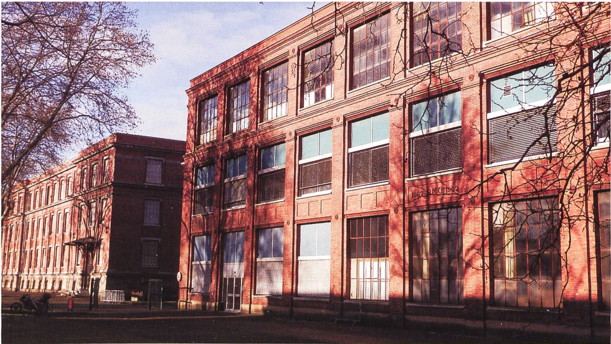
Abb. 3 Backsteinfabrikgebäude von DMC/Mülhausen.
