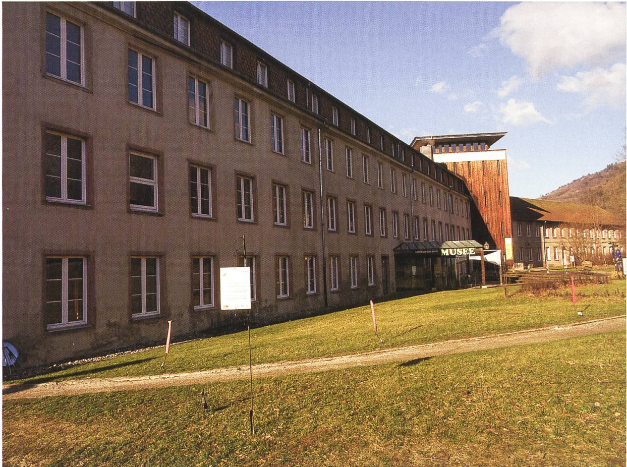
Abb. 7 Ehemalige Weberei der Stoffdruckerei Wesserling (Thurtal), eines der letzten verbliebenen Mehrstockfabrikgebäude, heute Museum. Foto: R. Michna
