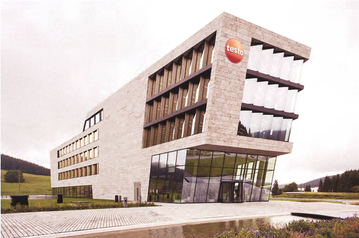
Abb. 3 Aufnahme des Firmengebäudes der Testo AG in Titisee-Neustadt.
