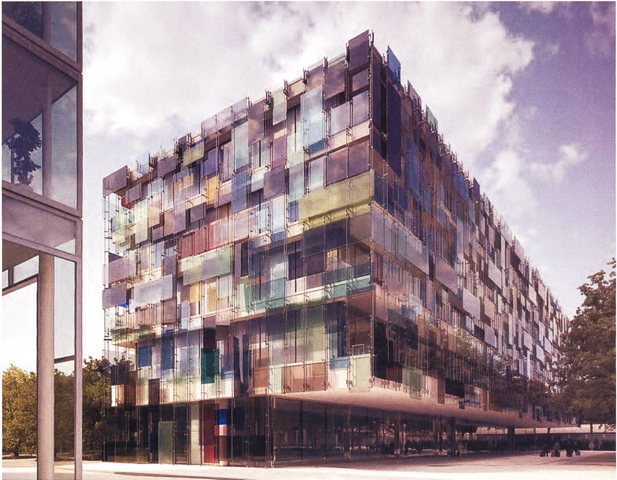
Abb. 4 Novartis Forum 3. Das Gebäude für die Büros der Hauptverwaltung von Novartis liegt am Hauptplatz des 20 ha großen Areals, das sich nördlich der Voltastrasse bis hin zur französischen Grenze erstreckt und von der Hüniger Strasse in einen größeren östlichen und einen kleineren westlichen Teil diagonal zerschnitten wird. ©Diener und Diener Architekten, Basel
