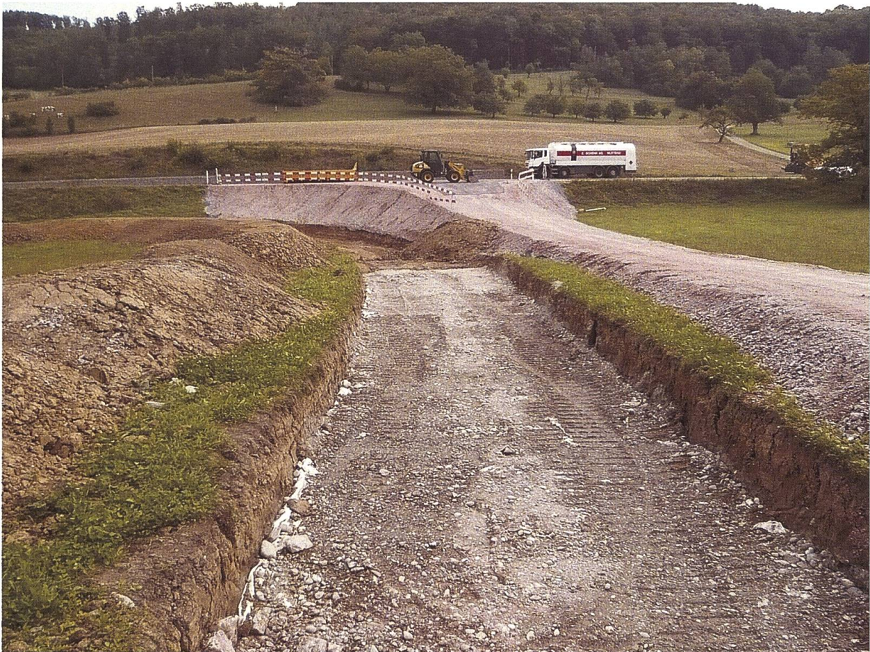
Abb. 3 Für die Errichtung des neuen Radweges wurde von der Kantonsstrasse mit dem Lastwagen eine > 50 cm mächtige Baupiste (lastverteilende Massnahme) geschüttet. Anschliessend wurde der Boden mit dem Raupenbagger rückschreitend abgetragen und seitlich zwischengelagert (Bodendepot links). Die Baupiste wurde anschliessend im rückschreitenden Verfahren wieder zurückgebaut. Mit diesen Massnahmen konnte gewährleistet werden, dass sich die Eingriffsfläche auf den Perimeter der neuen Strasse beschränkte und weitere Bodenflächen nicht direkt befahren wurden.
