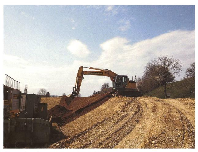
Abb. 5 Beim Anlegen von Bodenmaterial (Rekultivierung) steht der Bagger auf dem Ausgangsmaterial (C-Material, hier Dammmaterial) und schüttet bei trockenen Witterungs- und Bodenfeuchteverhältnissen das Unterbodenmaterial und anschliessend das Oberbodenmaterial lose mit einer Überhöhung von 20 %, um spätere Setzungen einzukalkulieren.
