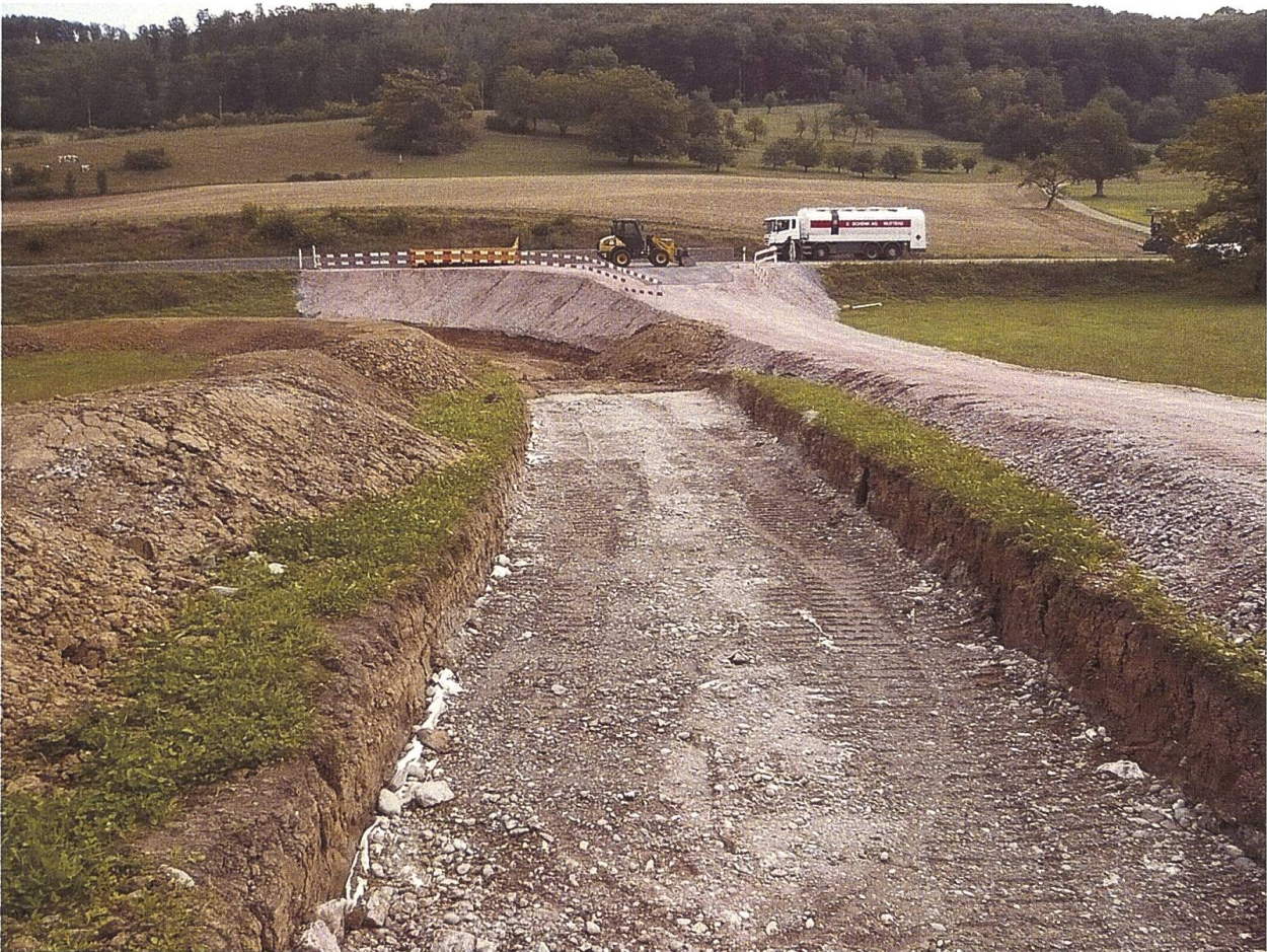
Abb. 3 Für die Errichtung des neuen Radweges wurde von der Kantonsstrasse mit dem Lastwagen eine > 50 cm mächtige Baupiste (lastverteilende Massnahme) geschüttet. Anschliessend wurde der Boden mit dem Raupenbagger rückschreitend abgetragen und seitlich zwischengelagert (Bodendepot links). Die Baupiste wurde anschliessend im rückschreitenden Verfahren wieder zurückgebaut. Mit diesen Massnahmen konnte gewährleistet werden, dass sich die Eingriffsfläche auf den Perimeter der neuen Strasse beschränkte und weitere Bodenflächen nicht direkt befahren wurden. Foto: Gruner AG, 18.8.2015
