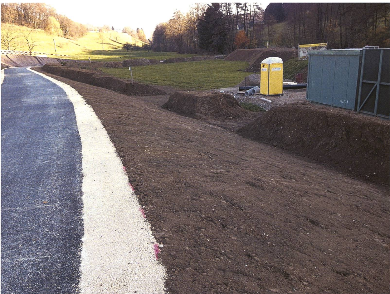
Abb. 4 Zwischengelagertes Bodenmaterial (Bodendepots) und rekultivierte Böschung (Vordergrund) entlang des neuen Radweges in Zeiningen. Die Bodendepots wurden im Anschluss an die Abtragsarbeiten errichtet und beschriftet. Das Material wurde erst bei den Rekultivierungsarbeiten wieder von den Depots entnommen (minimale Störung der Bodenstruktur), was eine geplante Baulogistik und genügend Platz für die Zwischenlagerflächen verlangte. Sichtbar sind die unterschiedlichen Schütthöhen von Oberboden (Vordergrund) und Unterboden (hinter WC-Anlage). Foto: Gruner AG, 11.11.2015
