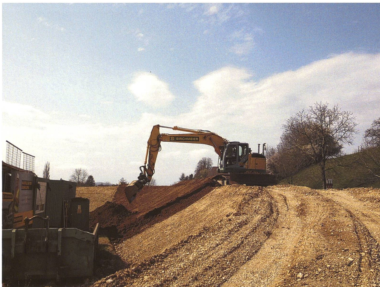
Abb. 5 Beim Anlegen von Bodenmaterial (Rekultivierung) steht der Bagger auf dem Ausgangsmaterial (C-Material, hier Dammmaterial) und schüttet bei trockenen Witterungs- und Bodenfeuchteverhältnissen das Unterbodenmaterial und anschliessend das Oberbodenmaterial lose mit einer Überhöhung von 20 %, um spätere Setzungen einzukalkulieren. Foto: Gruner AG, 4.4.2016
