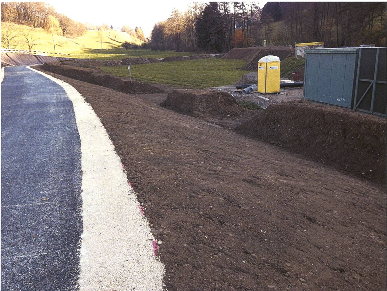
Abb. 4 Zwischengelagertes Bodenmaterial (Bodendepots) und rekultivierte Böschung (Vordergrund) entlang des neuen Radweges in Zeiningen. Die Bodendepots wurden im Anschluss an die Abtragsarbeiten errichtet und beschriftet. Das Material wurde erst bei den Rekultivierungsarbeiten wieder von den Depots entnommen (minimale Störung der Bodenstruktur), was eine geplante Baulogistik und genügend Platz für die Zwischenlagerflächen verlangte. Sichtbar sind die unterschiedlichen Schutthöhen von Oberboden (Vordergrund) und Unterboden (hinter WC-Anlage).
