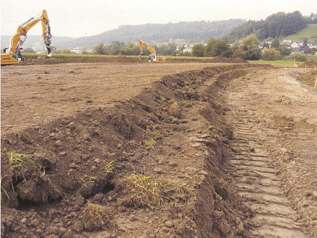
Abb. 2 Aufgrund der Erhebung des Ausgangszustandes wird das Rekultivierungsziel festgelegt. Nach der Erstellung der Rohplanie (rechts im Bild), erfolgt die Schüttung des Unterbodens (mittlerer Bereich) sowie des Oberbodens (linker Bereich), so dass die rekultivierten Flächen mindestens so gute Eigenschaften und Bodenmächtigkeiten aufweisen wie der Ausgangszustand und eine in allen Bereichen uneingeschränkte Nachnutzung möglich ist.
