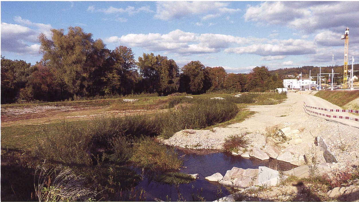
Abb. 10 Situation nach Abschluss der Bauarbeiten im beschriebenen Bereich. Einzig die Baupiste ganz rechts und die Neutralisationsanlage müssen zu einem späteren Zeitpunkt noch zurückgebaut und jener Bereich ebenfalls rekultiviert werden. Foto: Y. Schachenmann, 05.10.2016
