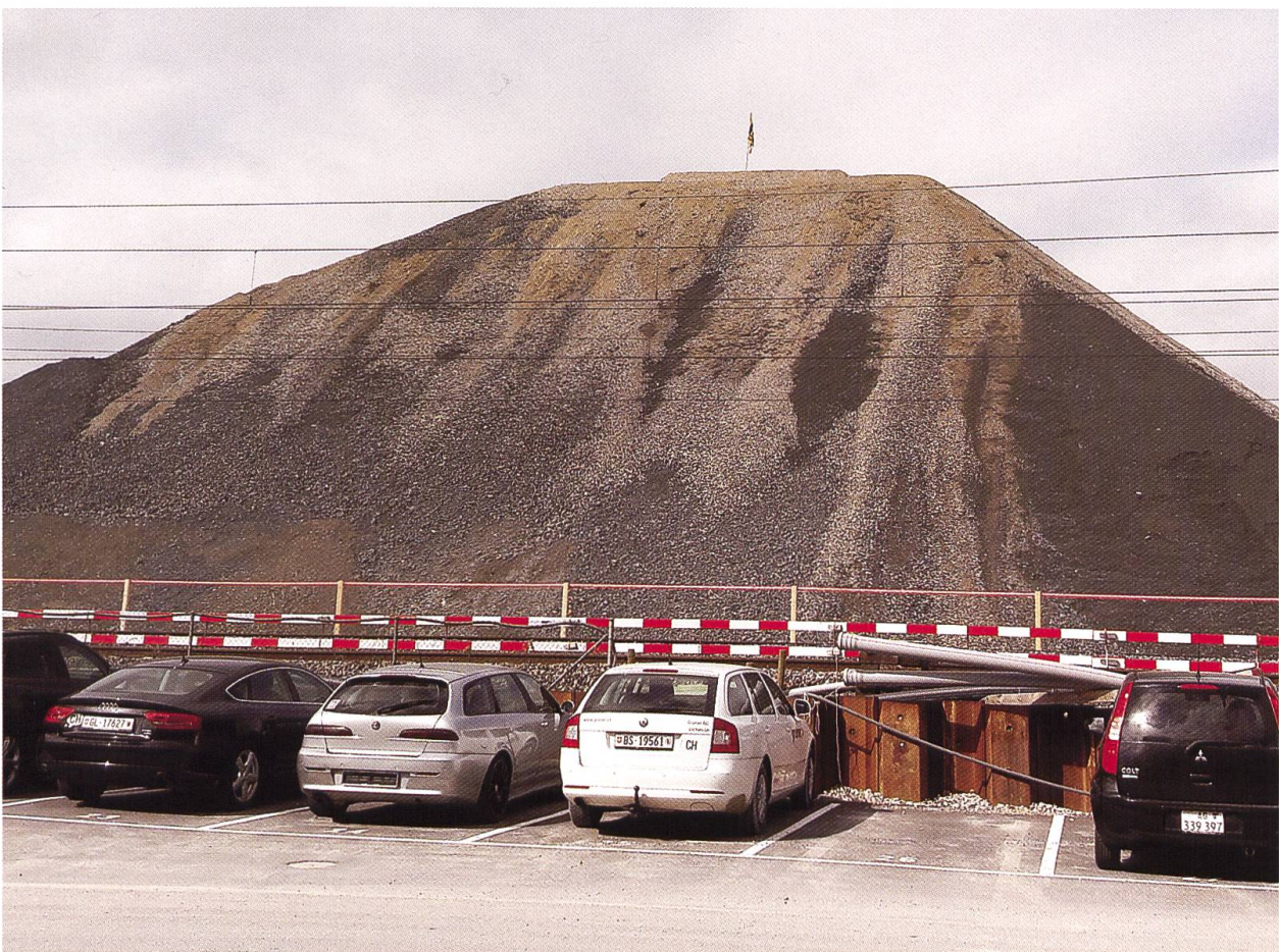
Abb. 3 Ausbruchmaterial-Zwischenlager in der Wöschnau.
