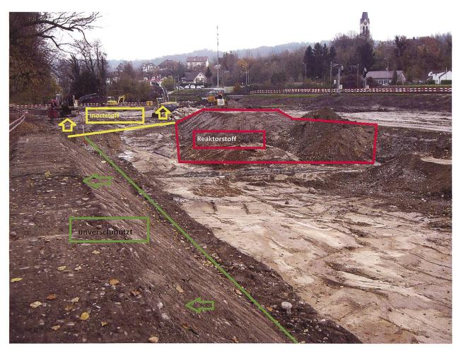
Abb. 6 Triage des Materials nach unterschiedlicher Materialqualität.
