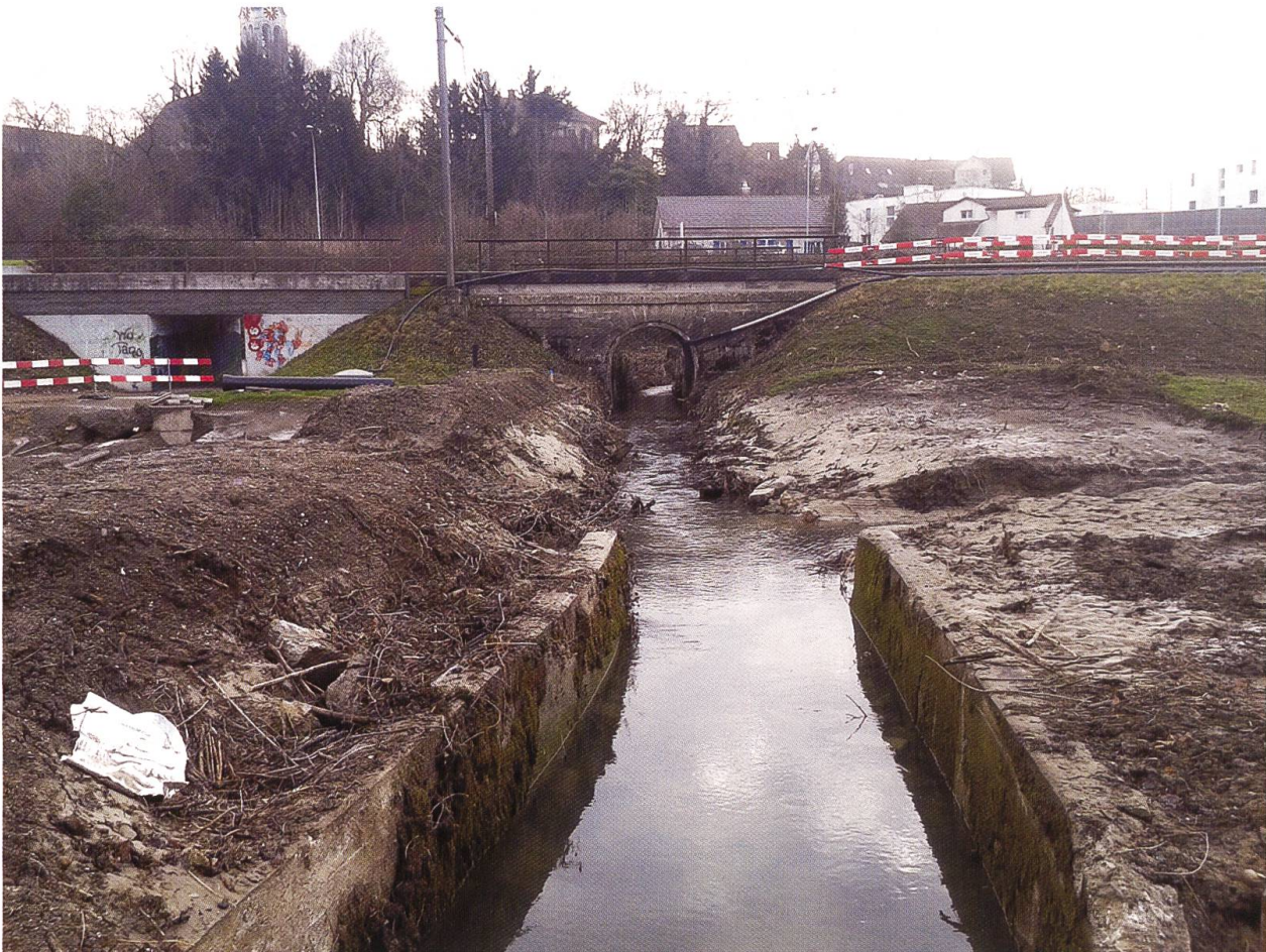
Abb. 5 Situation des eingefassten alten Bachlaufs vor der Aufwertung.
