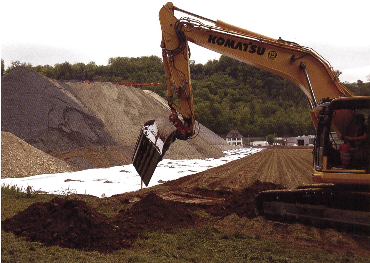
Abb. 4 Vergrösserung der Zwischenlagerfläche mittels Abhumusierung des Oberbodens aufgrund des Annahme-Stopps von Ausbruchmaterial des Eppenberg-Projektes in der SMDK.
