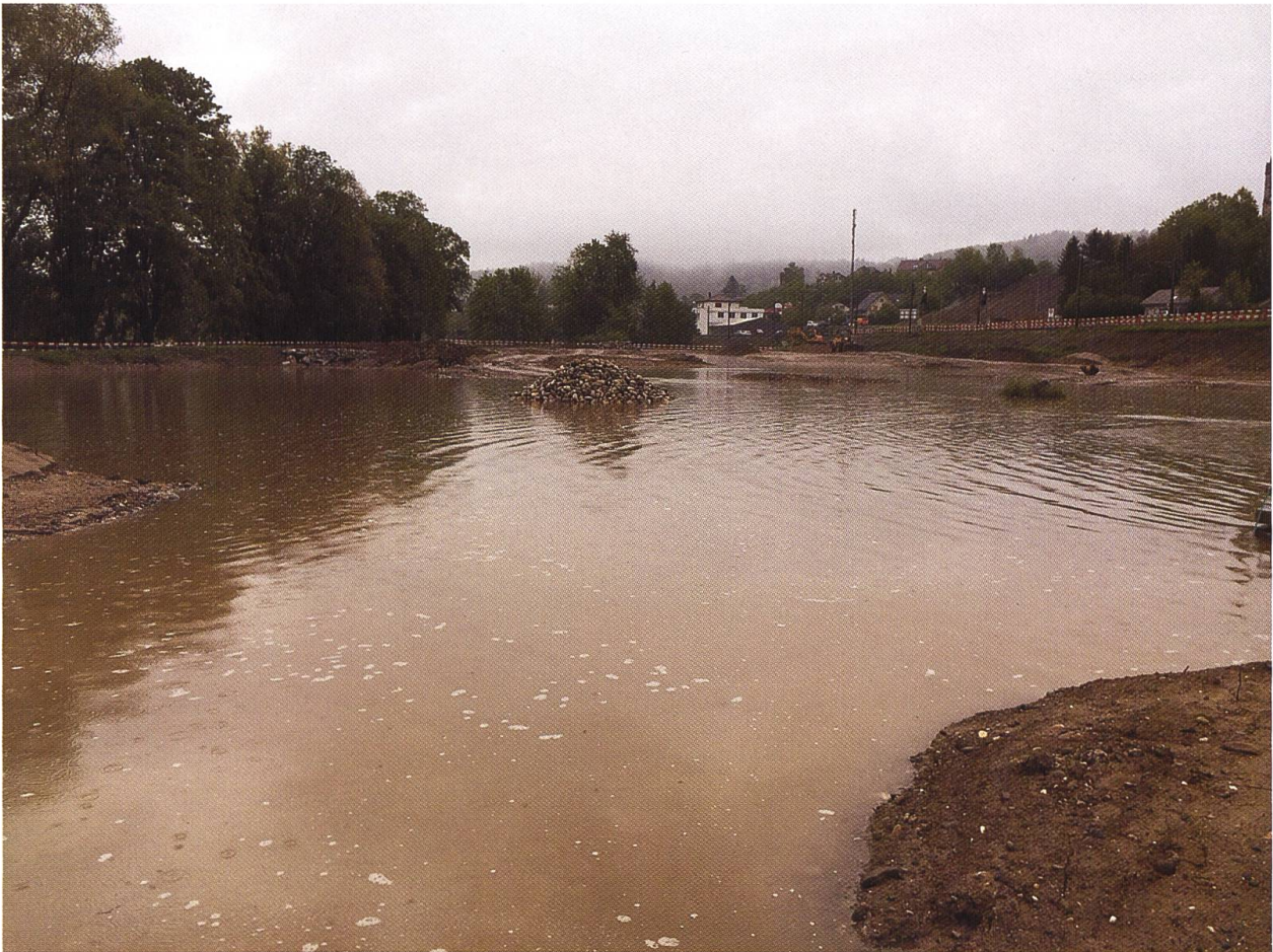
Abb. 8 Situation am neuen Bachlauf beim Hochwasserereignis Anfang Mai 2015 mit dem Rückstau der Aare in den Gretzenbach. Foto: Y. Schachenmann, 05.05.2015
