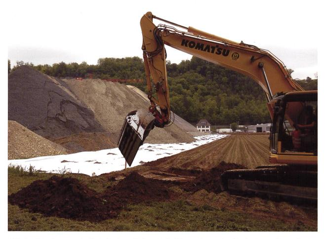
Abb. 4 Vergrösserung der Zwischenlagerfläche mittels Abhumusierung des Oberbodens aufgrund des Annahme-Stopps von Ausbruchmaterial des Eppenberg-Projektes in der SMDK.
