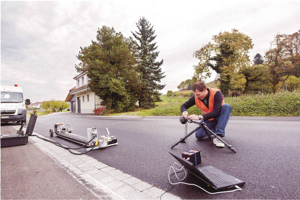
Abb. 4 Schallabsorptions-Luftströmungswiderstand- sowie Lasertexturmessungen auf einem lärmarmen Belag. Links im Bild befindet sich der 2 Meter lange Balken, an welchem der Laser befestigt ist, um die Oberflächentextur zu messen. Rechts montiere ich den Lautsprecher, welcher mit dem untenstehenden Mikrofon die Schallabsorption des Strassenbelages misst.
