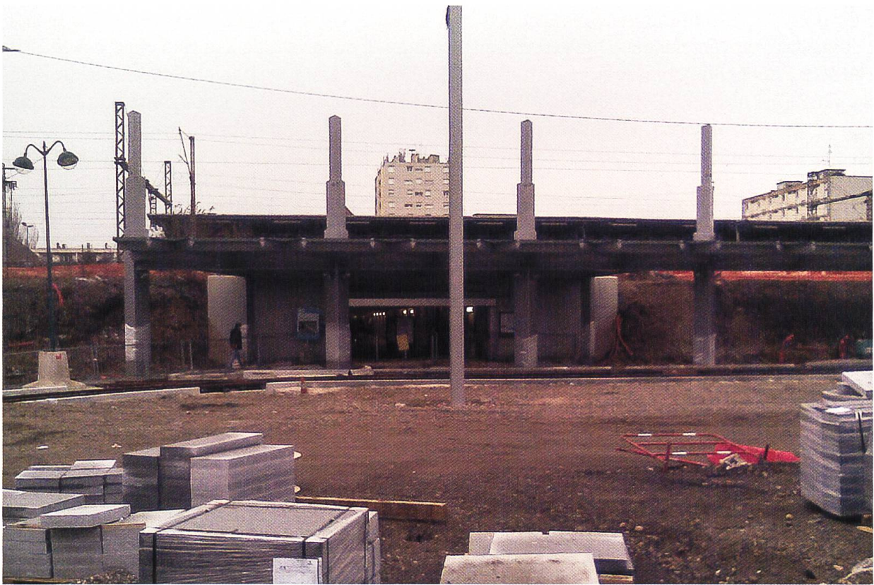
Abb. 3 Der Bahnhof Saint Louis als Endhaltestelle der Tramlinie 3 und zukünftige Drehscheibe im nachhaltigen Verkehr (Bahn, Tram, Bus, Velo). Foto: E.-J. Schröder, Januar 2017
