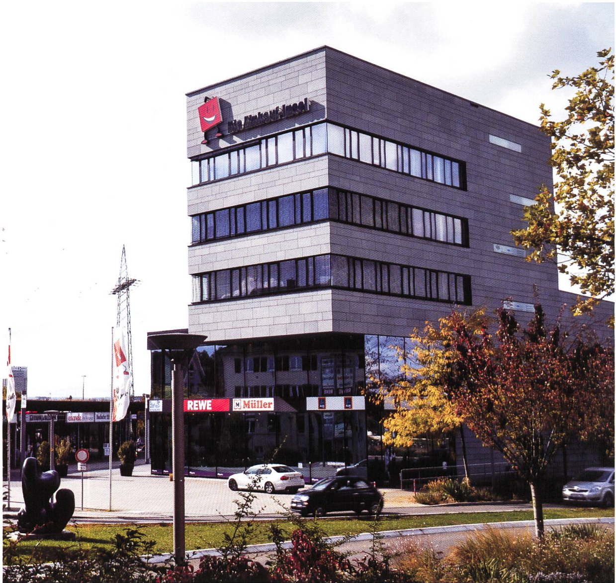
Abb. 3 Die Einkauf-Insel an der Hauptstrasse im westlichen Bereich der Kernstadt. In dem viergeschossigen Bau befinden sich diverse Shoppinggeschäfte, ein Lebensmittelmarkt sowie spezielle Dienstleister.
