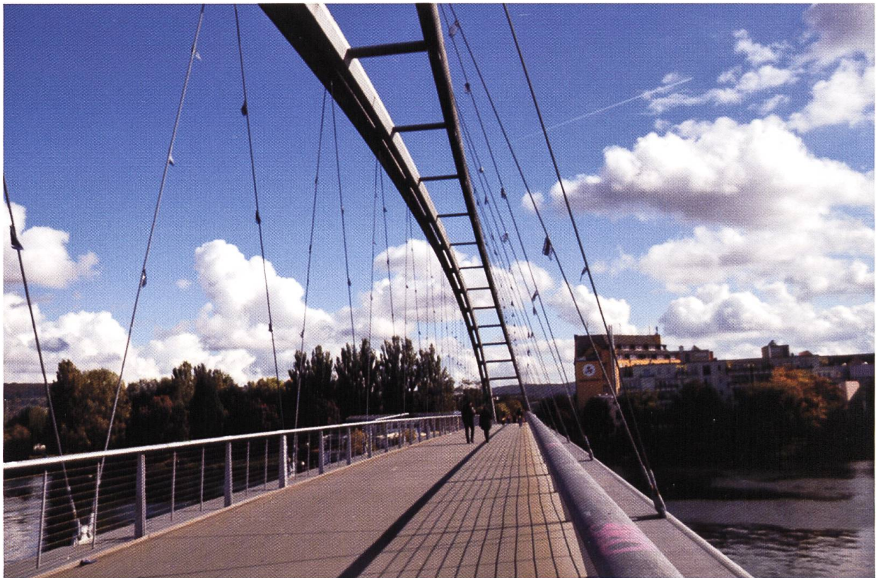
Abb. 1 Blick von der Dreiländerbrücke auf das Rhein-Center in Weil-Friedlingen. Sie bildet eine attraktive Verbindung für Fussgänger und Radfahrer im Dreiländereck. Foto: J.-W. Schindler
