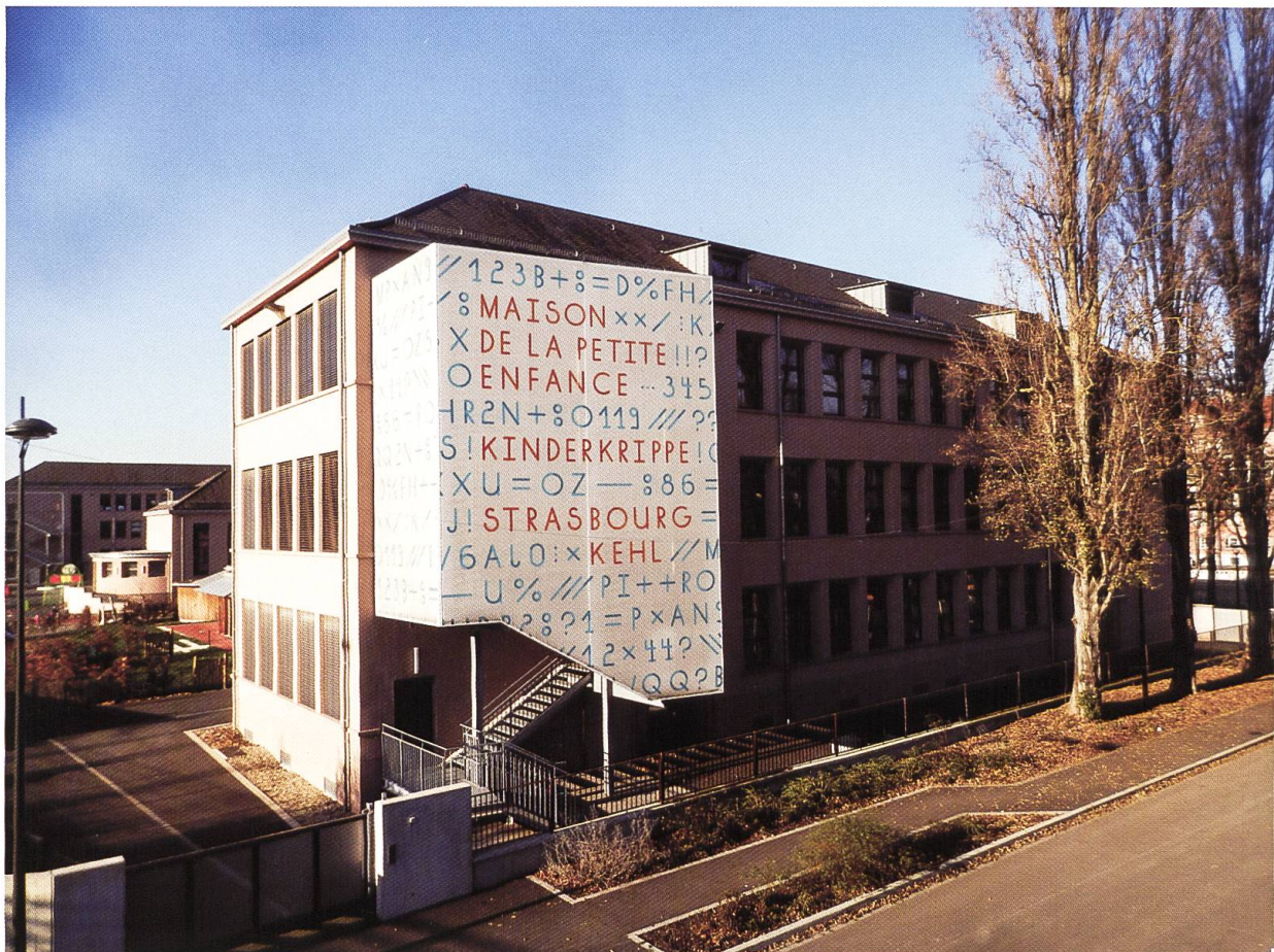
Abb. 3 Am westlichen Ende der Europabrücke wurde 2014 die deutsch-französische Kinderkrippe eröffnet. Foto: R. Michna
