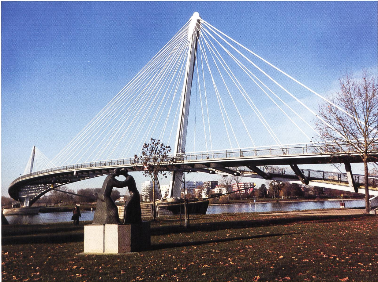
Abb. 2 Die über den Rhein gebaute “Brücke der zwei Ufer” (auch nach dem Architekten Mimram benannt) verbindet die anlässlich der grenzüberschreitenden Landesgartenschau 2004 auf beiden Seiten des Flusses angelegten Grünanlagen. Sie soll ebenso wie die Bronzeplastik “Begegnung” das Zusammenwachsen der beiden Rheinufer symbolisieren. Foto: R. Michna
