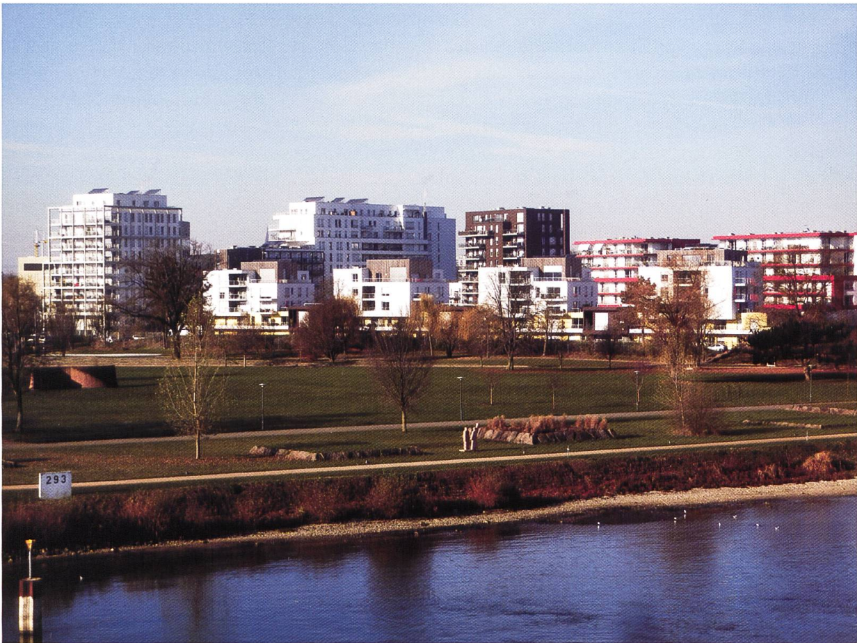
Abb. 4 Eine attraktive Waterfront mit Wohn- und Geschäftsimmobilien entstand nach 2014 am westlichen Rheinufer gegenüber von Kehl. Foto: R. Michna
