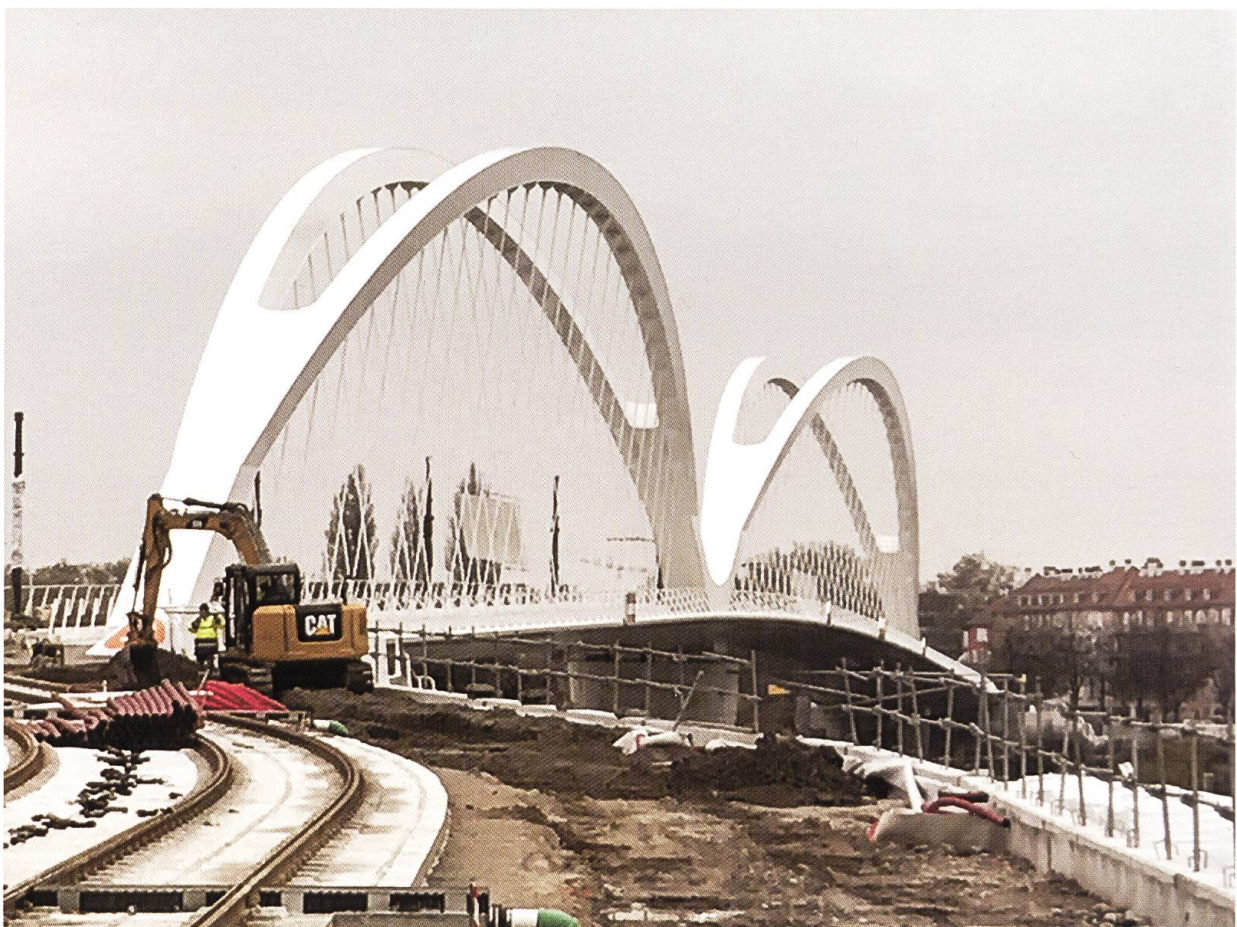
Abb. 3 Baustellenarbeiten an der Trambrücke Kehl-Strassburg.
