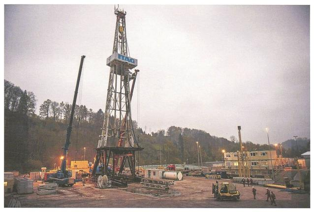
Abb. 2 Installationsplatz und Bohrturm des St. Galler Geothermie-Projekts im Sittertobel (vgl. auch 🕞). Durch die Arbeiten im Bohrloch ist ein Erdbeben der Stärke 3.5 ausgelöst worden (aus: *Schneeberger* 2014).
