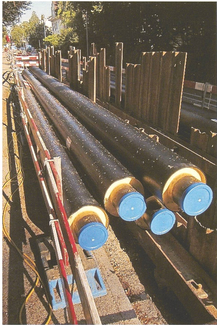
Abb. 7 Baustelle der Erweiterung des Fernwärmenetzes in Riehen, 23.06.2010. Foto: © Staatskanzlei Basel-Stadt
