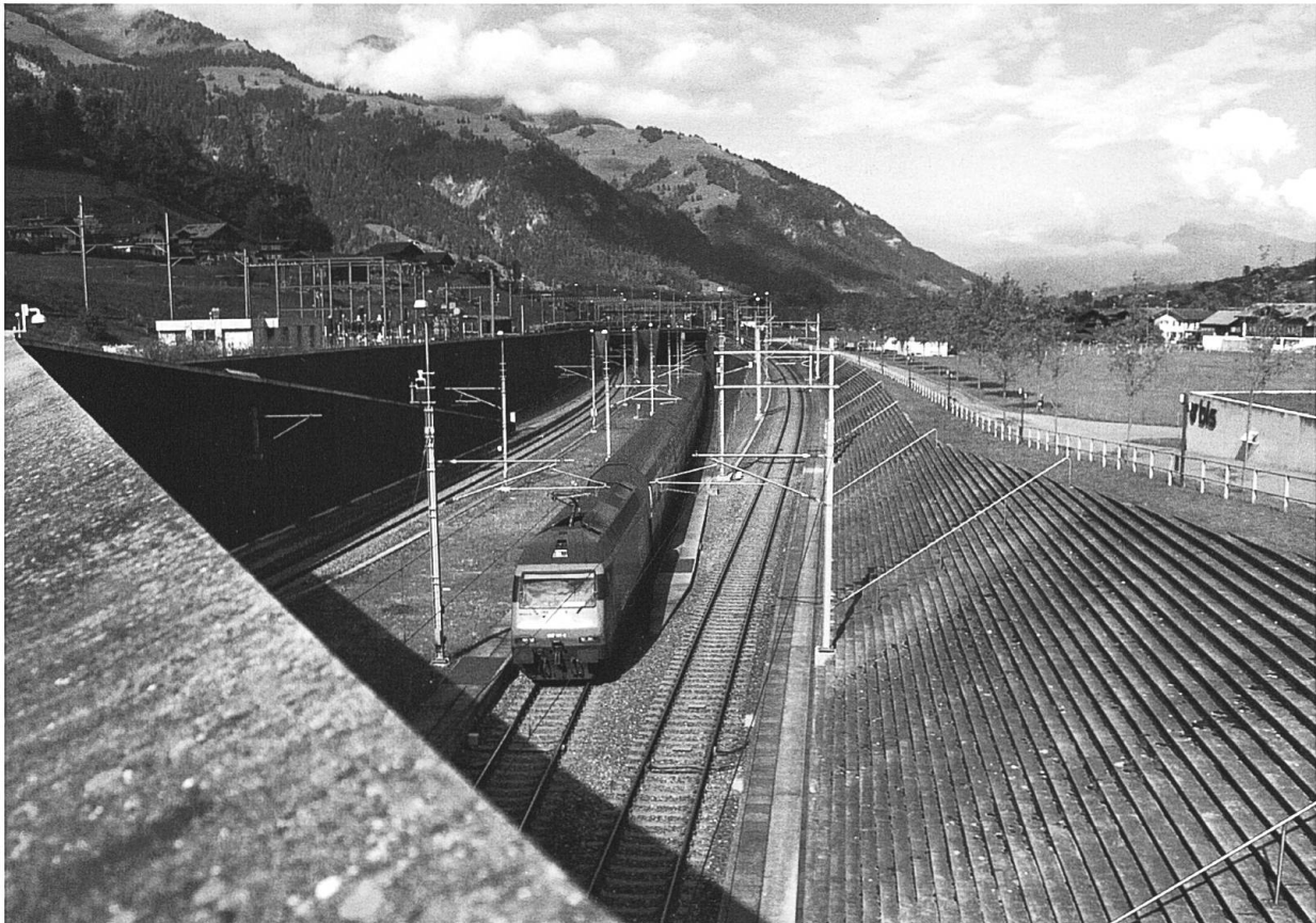
Abb. 5 Der stündlich verkehrende IC Romanshorn-Bern-Visp-Brig erreicht in Frutigen das Nordportal des LBT. Das doppelspurige Portal täuscht darüber hinweg, dass ein 21 km langer einspuriger Abschnitt folgt. Die beiden äusseren Gleise auf dem Bild binden den Bahnhof Frutigen an den LBT an, der Zug befindet sich auf jenem Gleis, das den Bahnhof einspurig unterquert und erst nördlich davon mit der Bestandesstrecke verknüpft ist. Der Bereich vor dem Tunnelportal ist als Interventions- und Nothaltestelle ausgebildet (links Zufahrtsrampe, rechts Fluchttreppe; 9. Oktober 2015).
