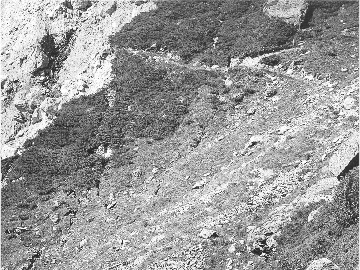
Abb. 3 Abrutschen des Pfades auf dem Weg zur Schreckhornhütte, oberhalb Stieregg (Stand 2012). Partien links im Bild sind vollständig erodiert. Auch der noch bestehende Teil ist bereits von Rissen durchzogen, lokal abgesackt und instabil. Foto: M. Bloch
