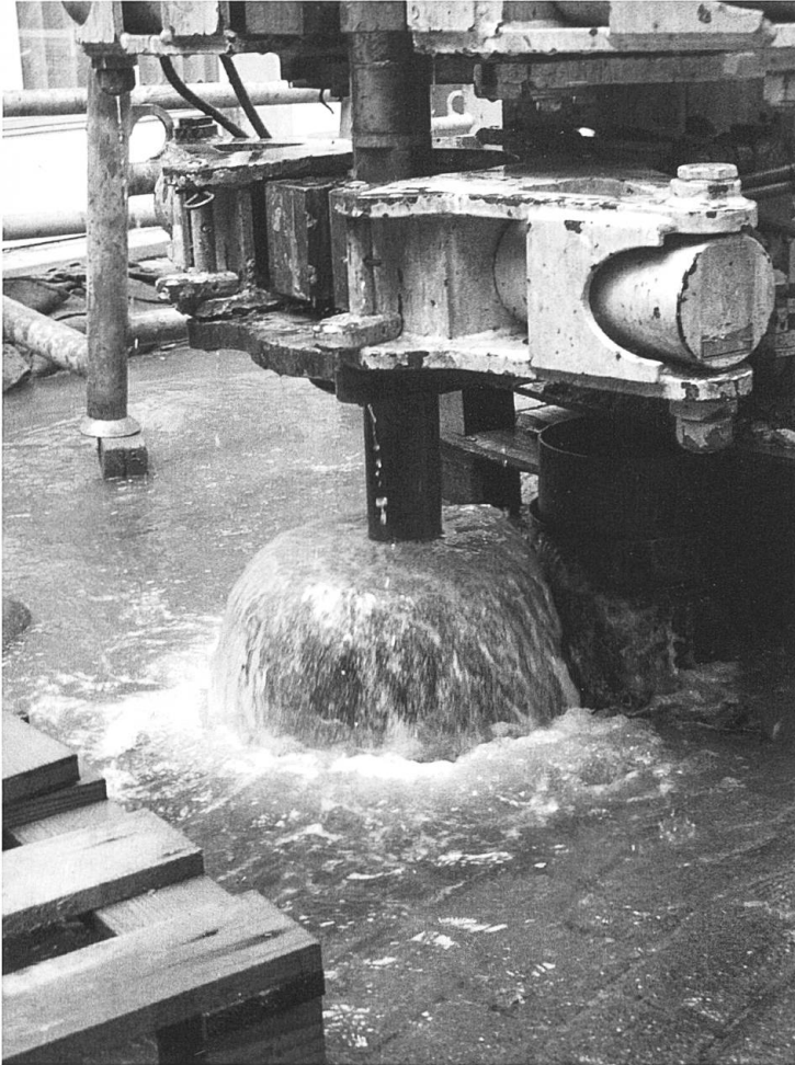
Abb. 1 Um das unzureichend verschlossene Bohrloch korrekt zu verschliessen, musste es 2010 erneut aufgebohrt werden. Bei einer Tiefe von 186 m wurde ein Holzpacker gesetzt, darüber wurde das Loch auszementiert. Das Foto zeigt den Arteser während der Bohrarbeiten im Jahr 2010.
