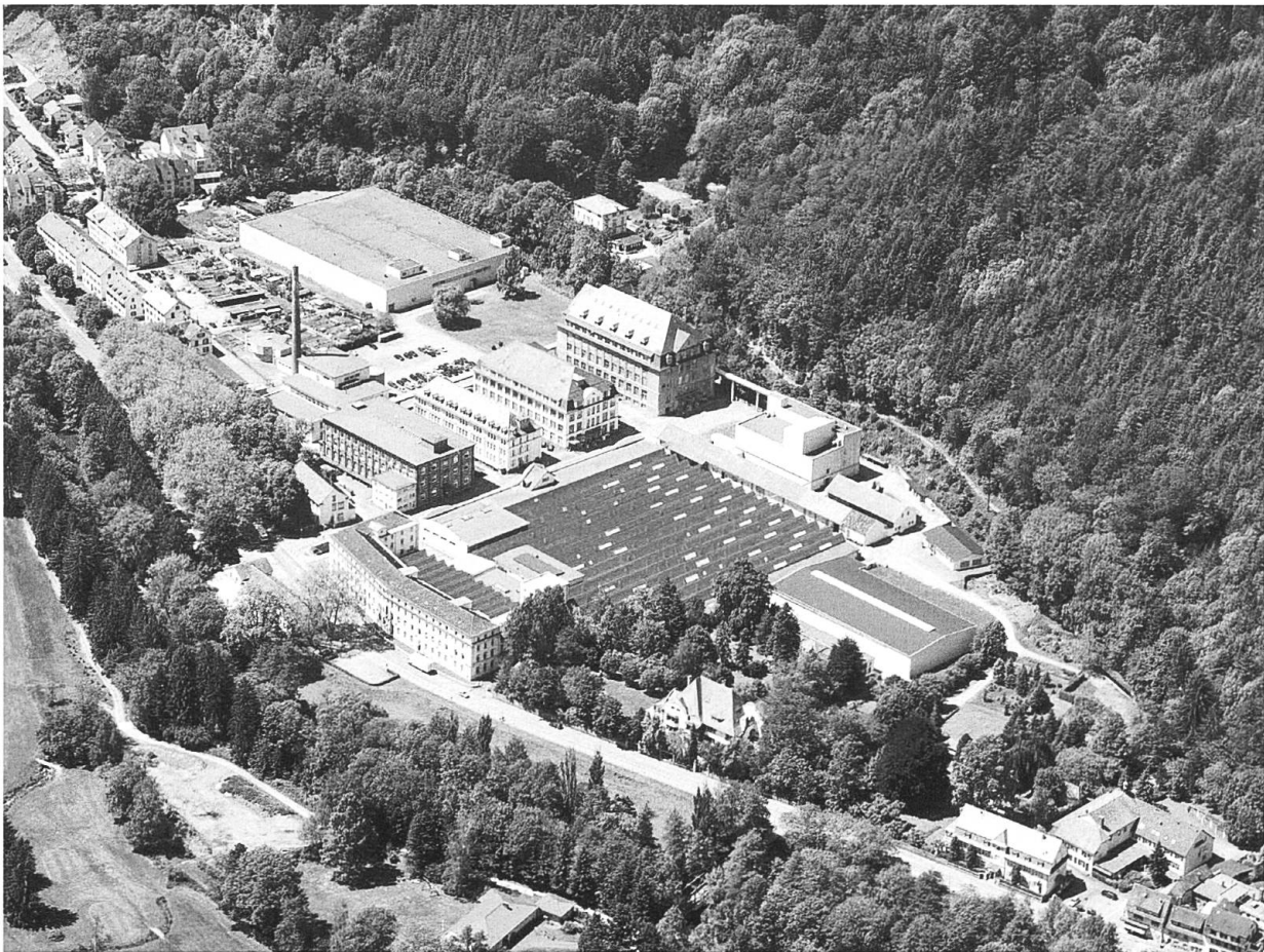
Abb. 1 Nähseidenfabrik Gütermann in Gutach/Breisgau.
