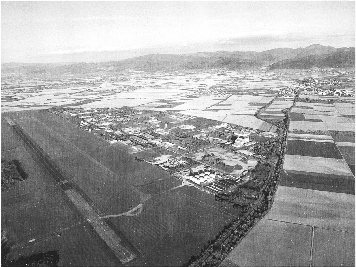
Abb. 1 Luftaufnahme des 1994 auf einem Militärflugplatz angelegten, interkommunalen Gewerbeparks "Breisgau" südlich von Freiburg. Neben der grossflächigen Thermischen Restabfallbehandlungs- und Energieerzeugungsanlage (TREA Breisgau) und einem Logistikzentrum von Lidl sind hier auch zahlreiche kleinere und mittlere Betriebe angesiedelt. Auch die fliegerische Nutzung für zivile Zwecke ist weiterhin möglich und daher ein positiver Standortfaktor.
