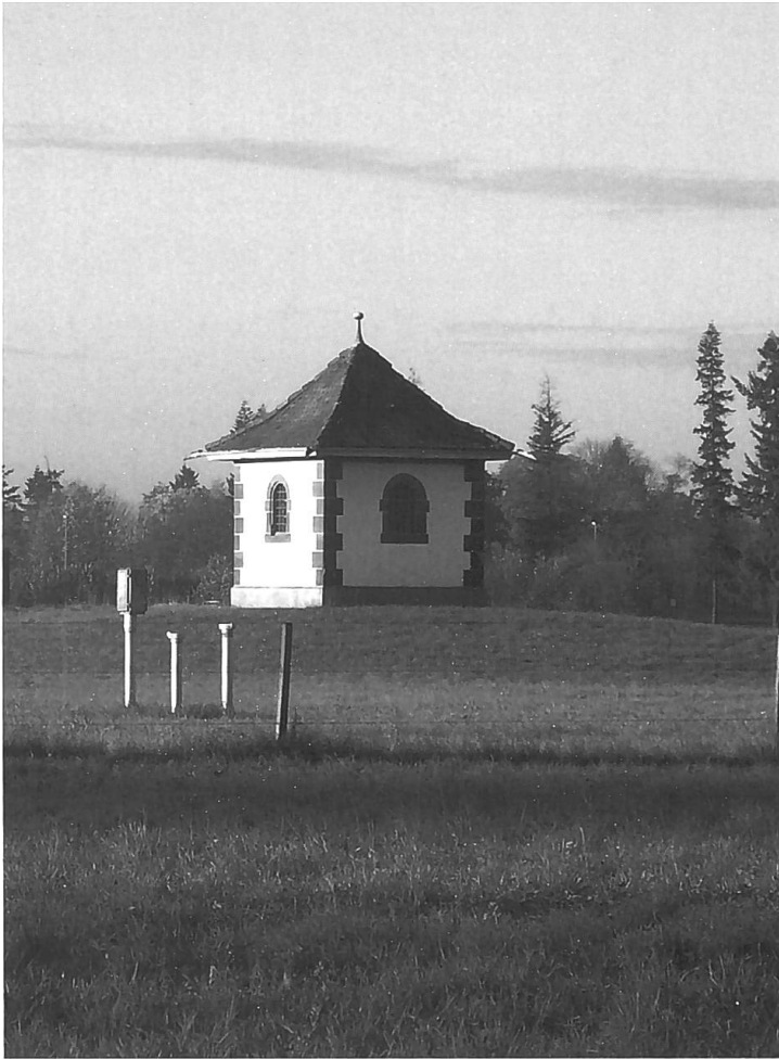
Abb. 1 Brunnenhäuschen (Brunnen 9) in den Langen Erlen im März 2006, im Vordergrund sind einige der zwischen Brunnen 9 und der Wasserstelle Hintere Stellmatten gelegenen Grundwasser-messstellen zu erkennen. Die historischen Brunnenhäuschen sind auffälliger als modernere schlichte Schachtabdeckungen ohne oberirdische Aufbauten. Zudem sind sie praktisch und bieten mitunter Raum und Infrastruktur für Versuchsinstallationen.
