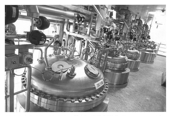
Abb. 1 Roche Basel, Biotech-Produktionsgebäude Bau 95. Die 2007 in Betrieb genommene neue Anlage ist nach modernsten Kriterien konzipiert und wird zur biotechnologischen Grossproduktion von Antikörpern und anderen Zellkulturprodukten eingesetzt.
