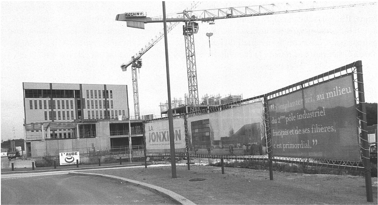
Fig. 3 Le centre d'affaires en construction.
