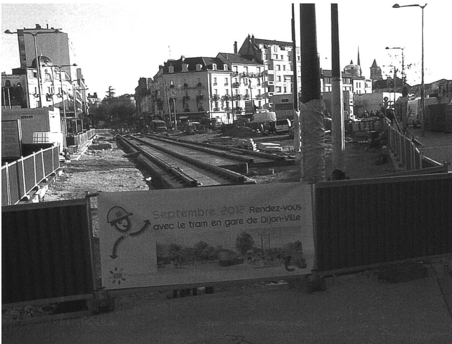
Abb. 5 Auch in Dijon erwies sich die 2012 reaktivierte und mit dem TGV-Bahnhof verknüpfte Strassenbahn (auf dem Bild noch im Bau) als wichtige städtebauliche Erneuerungsmassnahme und trug zur Attraktivitätssteigerung der City bei.
