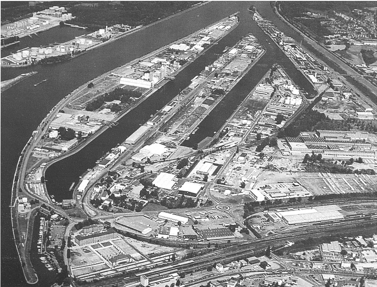
Abb. 3 Luftbild des Kehler Hafens. Quelle: Hafenverwaltung Kehl
