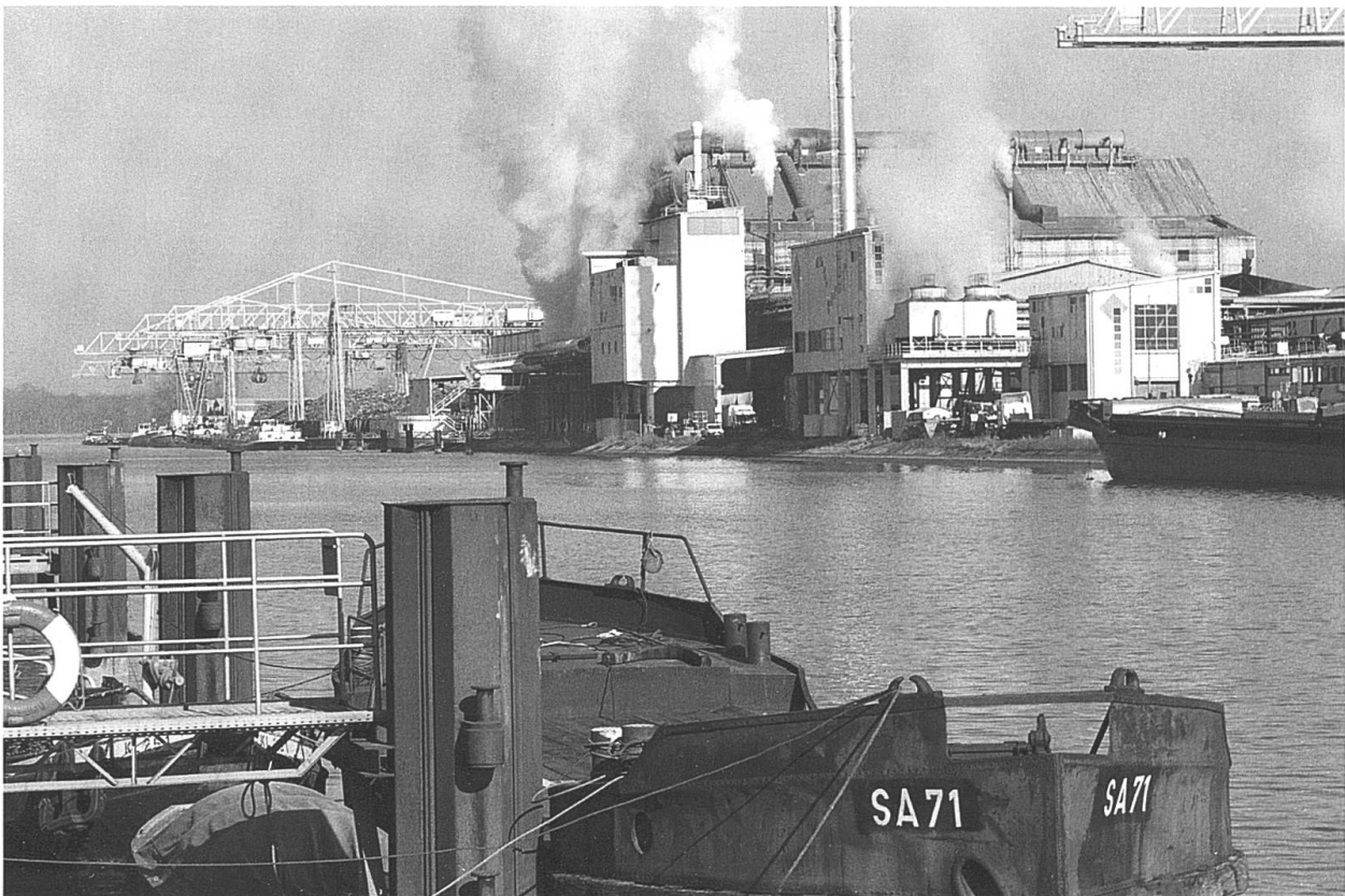
Abb. 1 Badische Stahlwerke GmbH im Hafen von Kehl.
