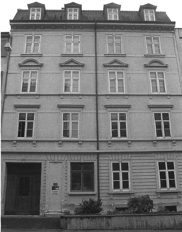
a) Gut unterhaltene Fassade ohne Farb- oder Verputzschäden
