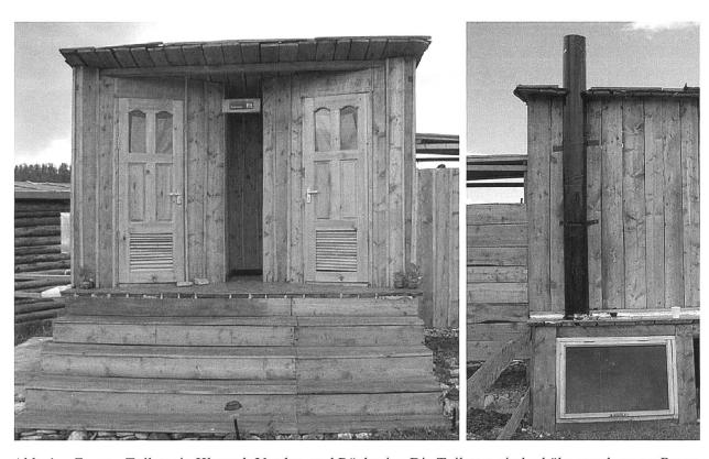
Abb. 1 Ecosan-Toilette in Khatgal: Vorder- und Rückseite. Die Toiletten sind erhöht, um darunter Raum für die Lagerung zu gewinnen. Lagerraum und Belüftungskamine sind auf der Rückseite (Süden) schwarz ausgekleidet. Durch die solare Erwärmung wird ein Luftzug generiert, der hilft, die Fäkalien auszutrocknen (Dehydrationstoilette) und Geruchsentwicklungen vorzubeugen.
