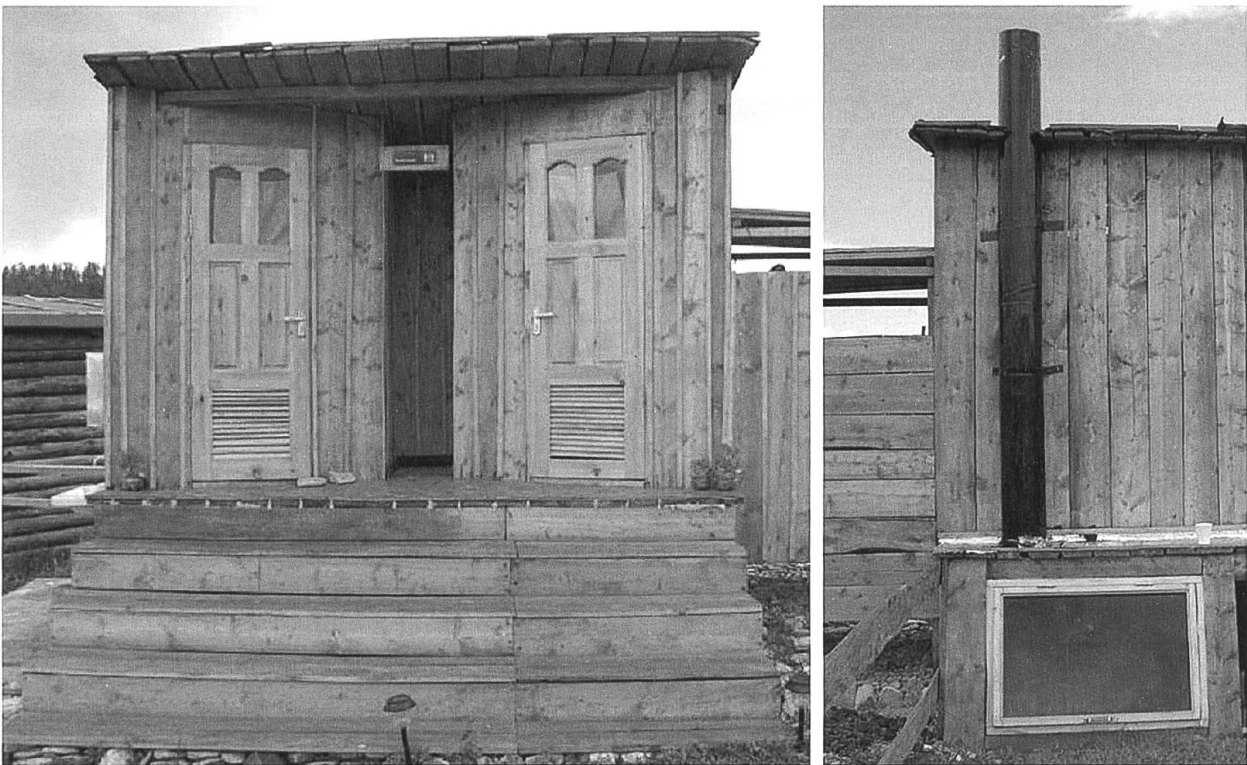
Abb. 1 Ecosan -Toilette in Khatgal: Vorder- und Rückseite. Die Toiletten sind erhöht, um darunter Raum für die Lagerung zu gewinnen. Lagerraum und Belüftungskamine sind auf der Rückseite (Süden) schwarz ausgekleidet. Durch die solare Erwärmung wird ein Luftzug generiert, der hilft, die Fäkalien auszutrocknen (Dehydrationstoilette) und Geruchsentwicklungen vorzubeugen.
