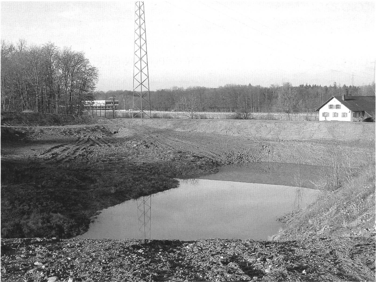
Abb. 1 Das Rückhaltebecken in der Kiesgrube Burstel im "Rohbau". Das ganze Gelände ist zu einem Naturschutzobjekt umgewandelt worden, das den oberflächlichen Abfluss von den obenliegenden Ackerflächen bremsen soll.
