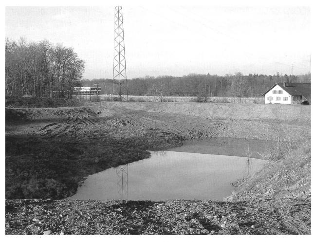
Abb. 1 Das Rückhaltebecken in der Kiesgrube Burstel im "Rohbau". Das ganze Gelände ist zu einem Naturschutzobjekt umgewandelt worden, das den oberflächlichen Abfluss von den obenliegenden Ackerflächen bremsen soll.
