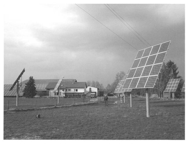
Abb. 2 Gebäudeintegrierte sowie dem Sonnenstand nachgeführte Solaranlagen des Schäferhofes bei Donaueschingen; Leistung insgesamt: 121 kWp (kW<sub>peak</sub>; Peakleistung = Spitzenleistung).
