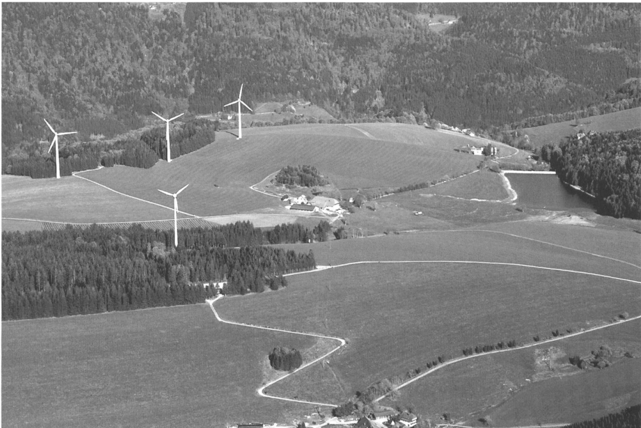
Abb. 1 Windkraftanlagen oberhalb von St. Peter/Schwarzwald beim Plattenhof. Die Jahresstromerzeugung der vier Windräder beträgt 7 Mio. kWh. Foto: F. Ehret, April 2007
