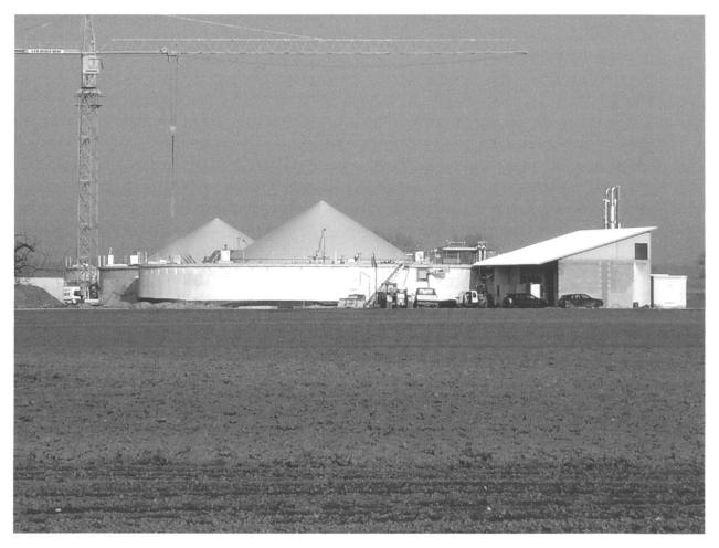
Abb. 4 Die 1.8 MW grosse Biogasanlage bei Forchheim im nördlichen Kaiserstuhlvorland verwertet den Aufwuchs von über 500 ha Ernteflächen.
