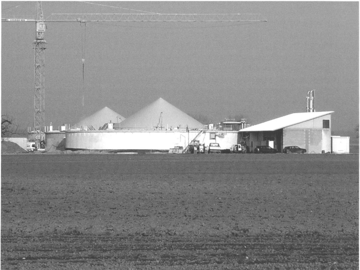
Abb. 4 Die 1.8 MW grosse Biogasanlage bei Forchheim im nördlichen Kaiserstuhlvorland verwertet den Aufwuchs von über 500 ha Ernteflächen. Foto: B. Mohr, März 2007
