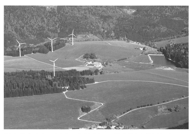
Abb. 1 Windkraftanlagen oberhalb von St. Peter/Schwarzwald beim Plattenhof. Die Jahresstromerzeugung der vier Windräder beträgt 7 Mio. kWh.
