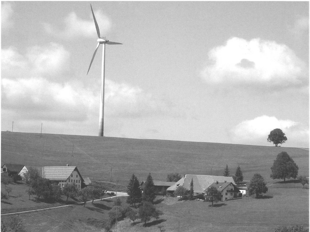
Abb. 5 Über Solar-, Windkraft- und Biogasanlagen wird in Freiamt nördl. von Freiburg i.Br. mehr Strom erzeugt (14 Mio. kWh/Jahr) als verbraucht wird. Foto: B. Mohr, Mai 2007
