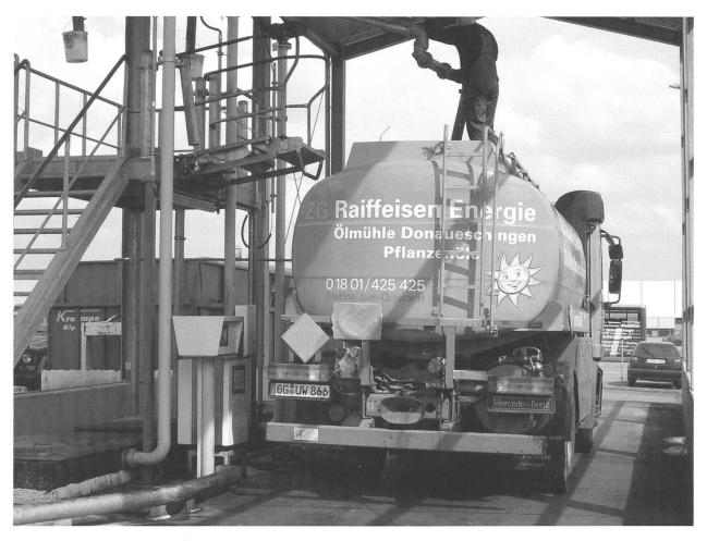
Abb. 6 Abfüllanlage der Ölmühle Donaueschingen. Rapsöl wird als Kraftstoff vor allem in Fahrzeugen von Speditionen eingesetzt. Foto: B. Mohr, April 2007
