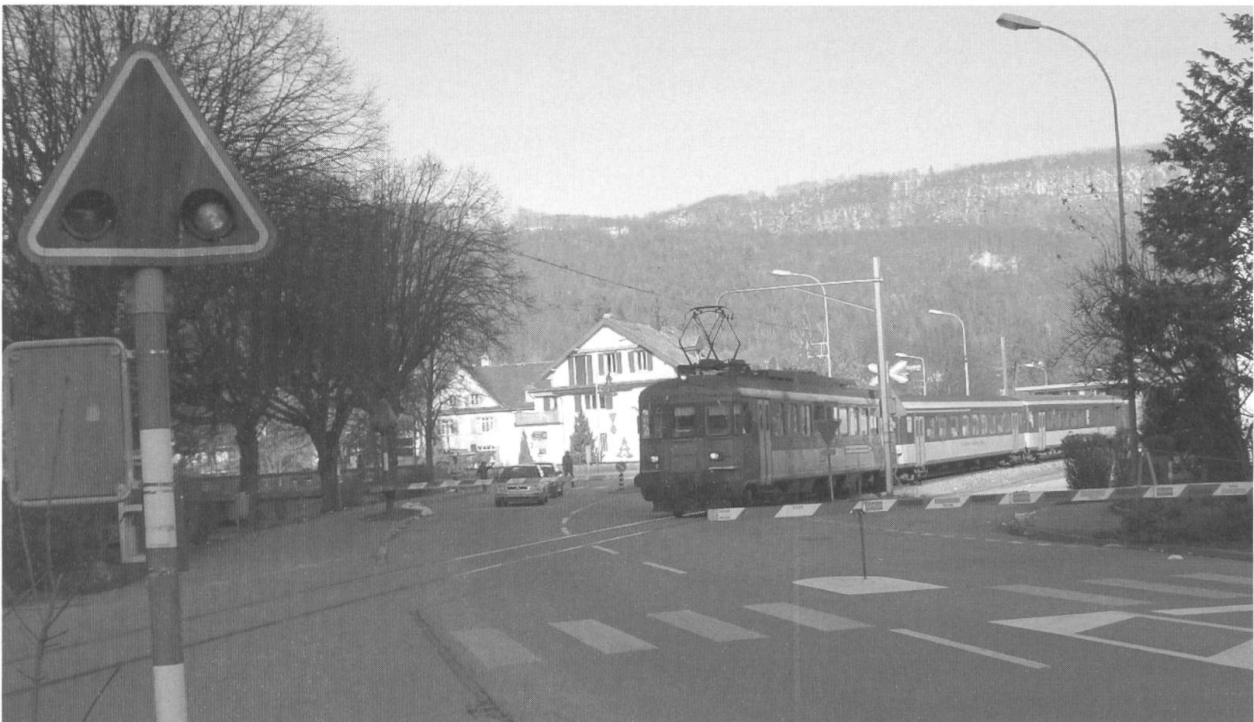
Abb. 5 Bei der Haltestelle Thalbrücke in Balsthal kreuzen sich Strasse und Schiene. Hier könnte möglicherweise in Zukunft ein Umsteigeknoten entstehen. Photo: Pascal Straub
