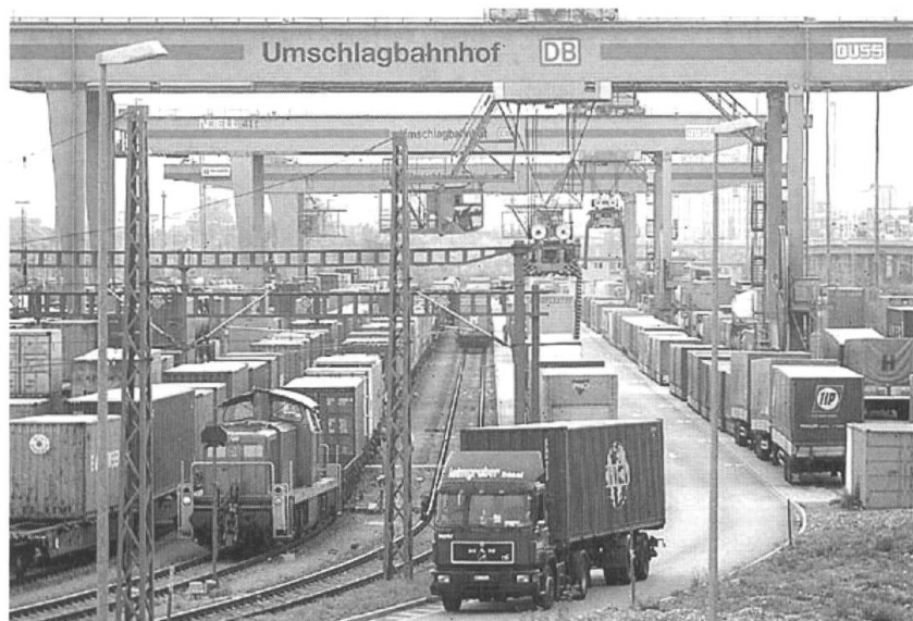
Abb. 2 Detailansicht des Umschlagbahnhofs mit den Verladegleisen und den drei Portalcränen.
