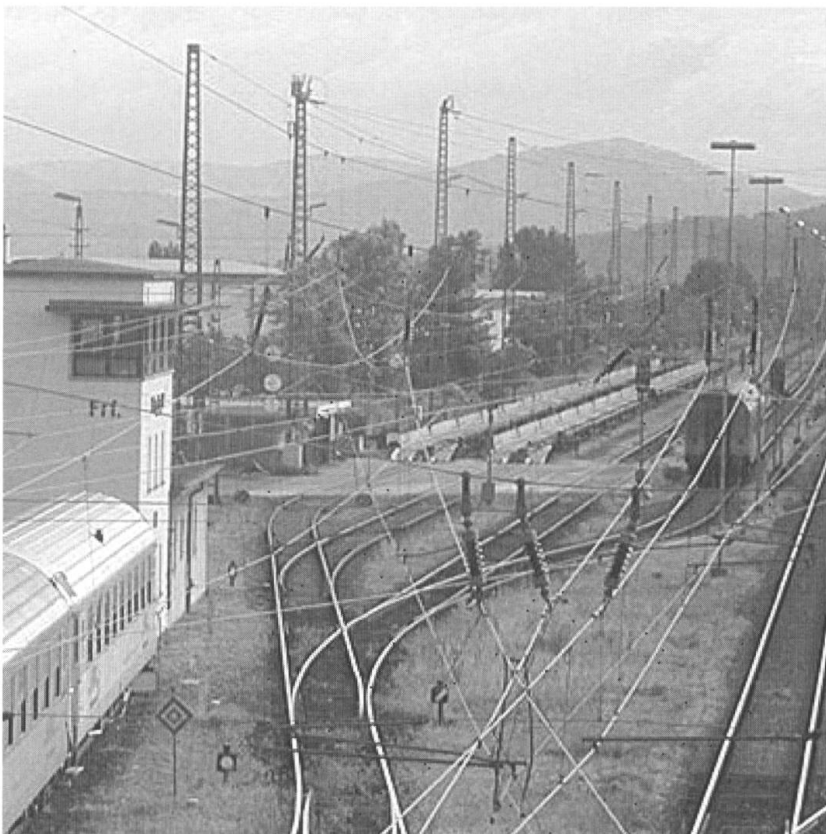
Abb. 3 Terminal der Rollenden Landstrasse Freiburg i. Br. – Novara in Freiburg.
