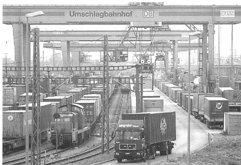
Abb. 2 Detailansicht des Umschlagbahnhofs mit den Verladegleisen und den drei Portal Kränen.
