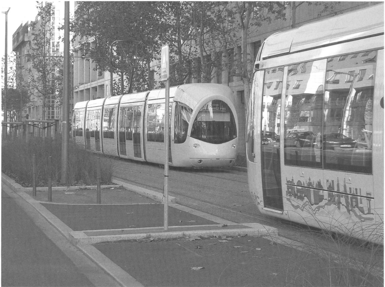
Abb. 5 Eigene Spuren machen den Trambetrieb wirtschaftlicher und sind bei modernen Tramsystemen Standard: Tramtrasse in Lyon, nahe des Bahnhofs Part-Dieu. Photo: Alain Groff
