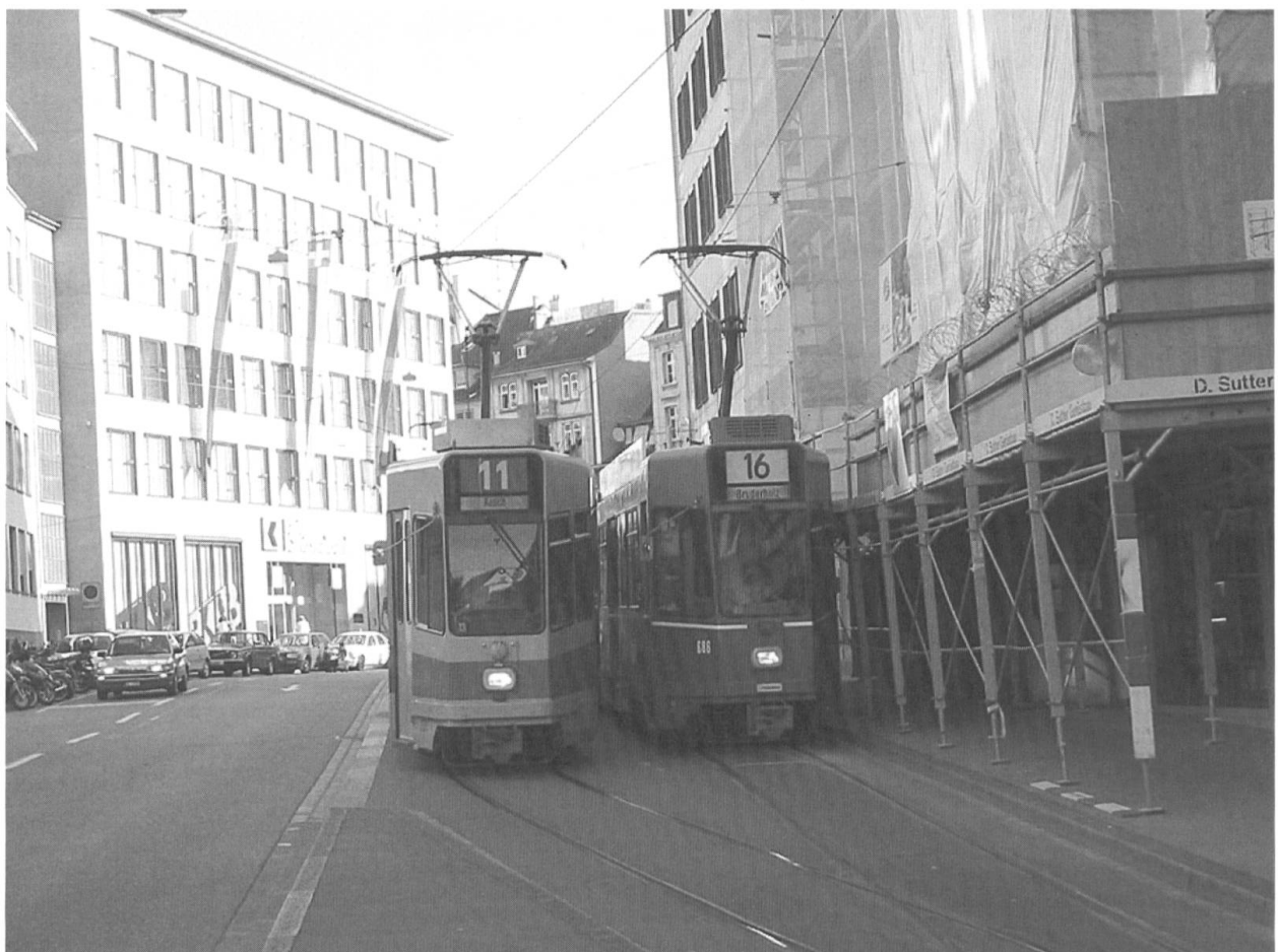
Abb. 3 Im historisch gewachsenen Basler Tramnetz sind die Platzverhältnisse eng: Diese Gleisanlage in der Spiegelgasse wurde 2004 im Interesse der Sicherheit und Leistungsfähigkeit umgebaut.
