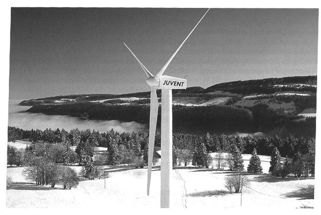
Abb. 5 Windkraftanlagen auf dem Mont-Crosin bei St-Imier, im grössten Windpark der Schweiz. Insgesamt sind acht Anlagen mit einer Gesamtleistung von 7.66 MW installiert, welche rund 8 GWh Strom erzeugen.
