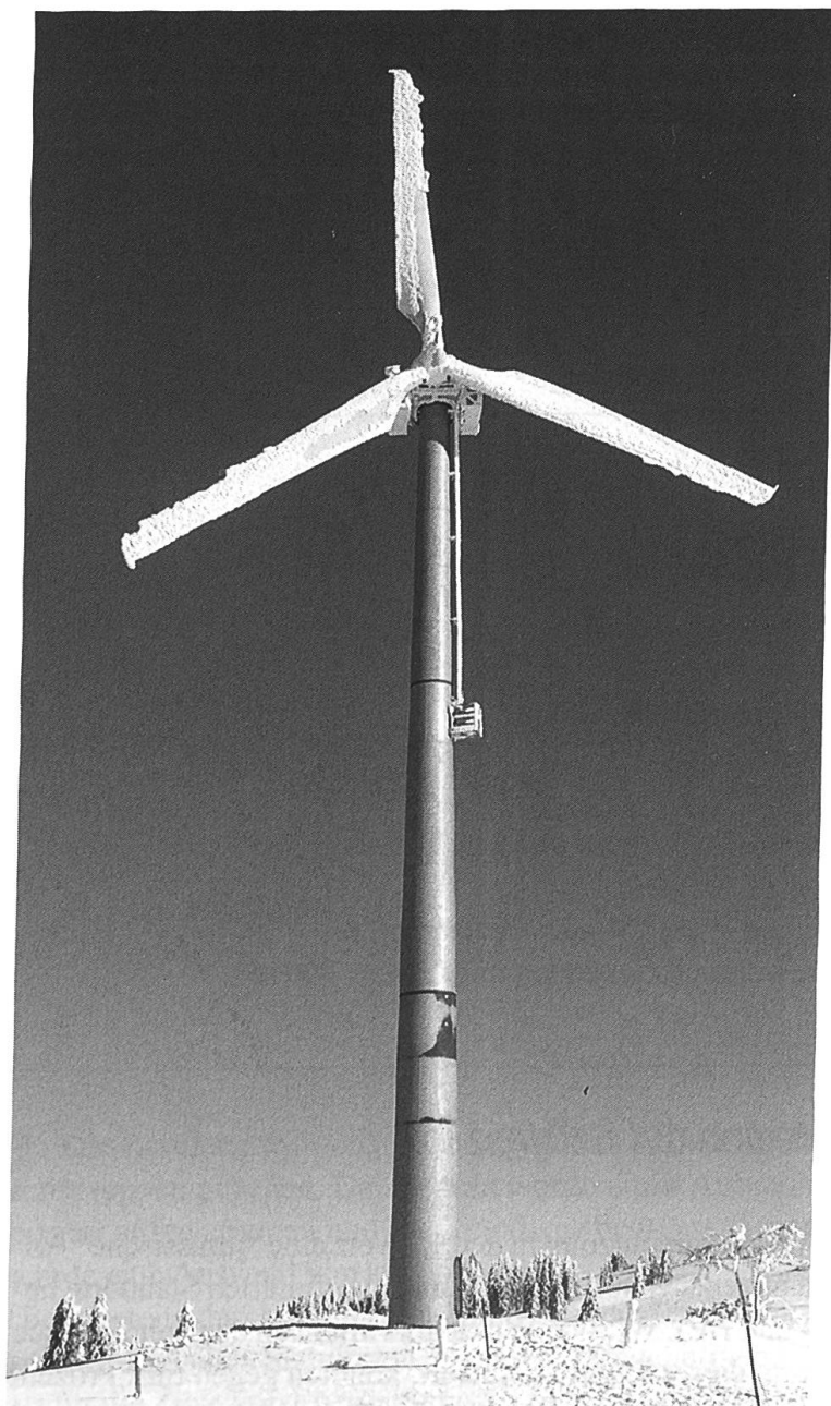
Abb. 4 150 kW-Windkraftanlage auf dem Grenchenberg im Solothurner Jura mit Raureif-Ansatz an den Rotorblättern. Dieser Raureif beeinflusst die Aerodynamik der Anlage und führt dadurch zu einem Minderertrag von Elektrizität. In moderneren Anlagen sind Blattheizungen installiert, um auch bei unwirtschaftlichen klimatischen Bedingungen Energie mit einem optimalen Wirkungsgrad erzeugen zu können. Photo: ADEV
