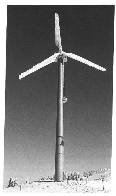
Abb. 4 150 kW-Windkraftanlage auf dem Grenchenberg im Solothurner Jura mit Raureif-Ansatz an den Rotorblättern. Dieser Raureif beeinflusst die Aerodynamik der Anlage und führt dadurch zu einem Minderertrag von Elektrizität. In moderneren Anlagen sind Blattheizungen installiert, um auch bei unwirtlichen klimatischen Bedingungen Energie mit einem optimalen Wirkungsgrad erzeugen zu können. *Photo: ADEV*
