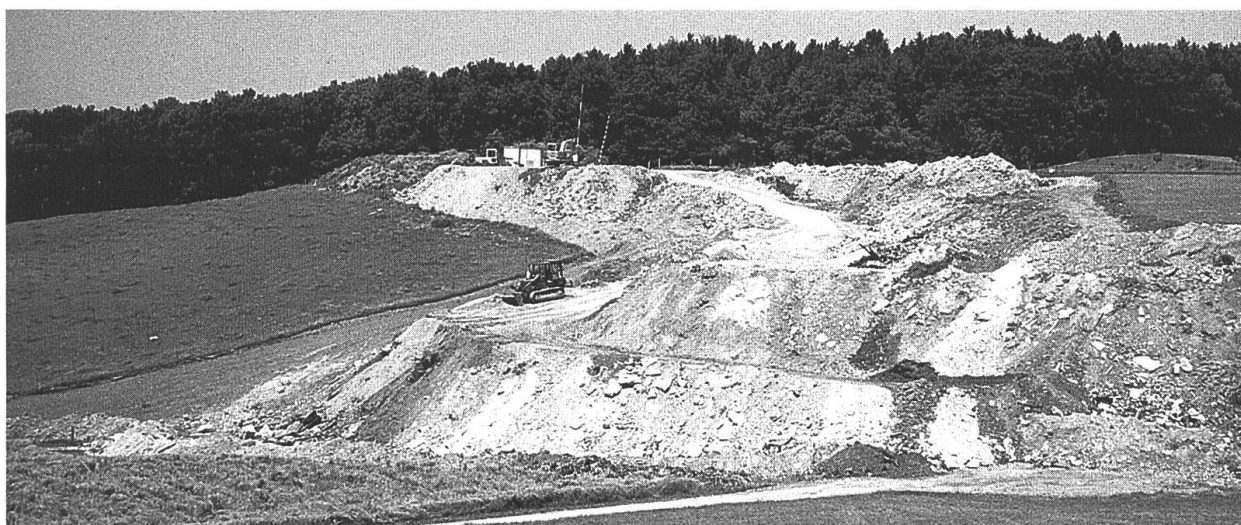
Abb. 3 Eine zeitgemässe Inertstoffdeponie, in der jede Anlieferung kontrolliert und das Material anschliessend schichtweise eingebaut wird. Die offene Betriebsfläche beansprucht stets nur einen kleinen Teil des bewilligten Deponieperimeters.
