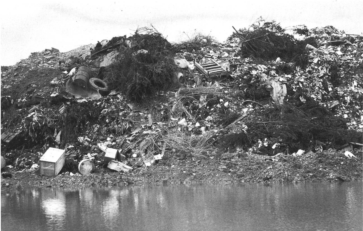
Abb. 1 Eine typische Kehrichtgrube in den 1960er Jahren im Birstal. Die Abfälle wurden über die Böschung in die frühere Kiesgrube abgekippt und zeitweise angezündet.
