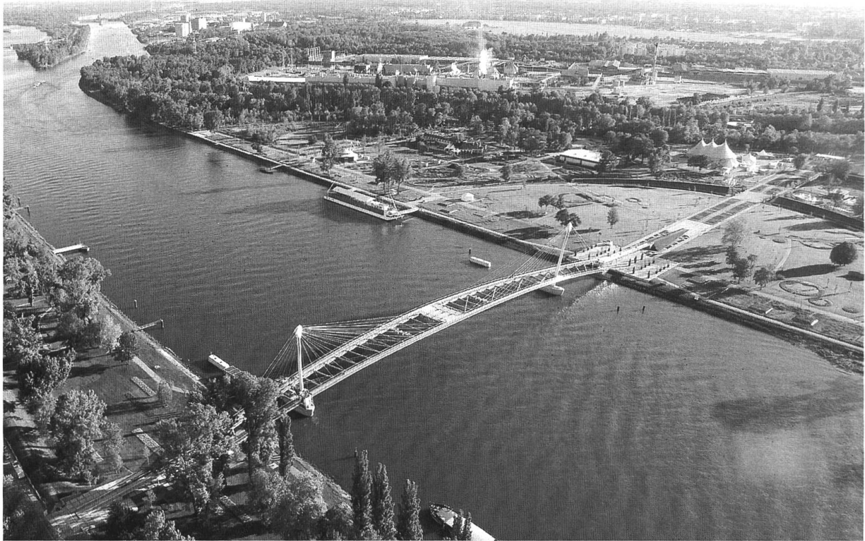
Abb. 1 Die Passerelle – eine neue Brückenverbindung für Fussgänger und Radfahrer zwischen Kehl und Strasbourg –, die zur Landesgartenschau fertiggestellt wurde. Photo: Tilmann Krieg, Kehl
